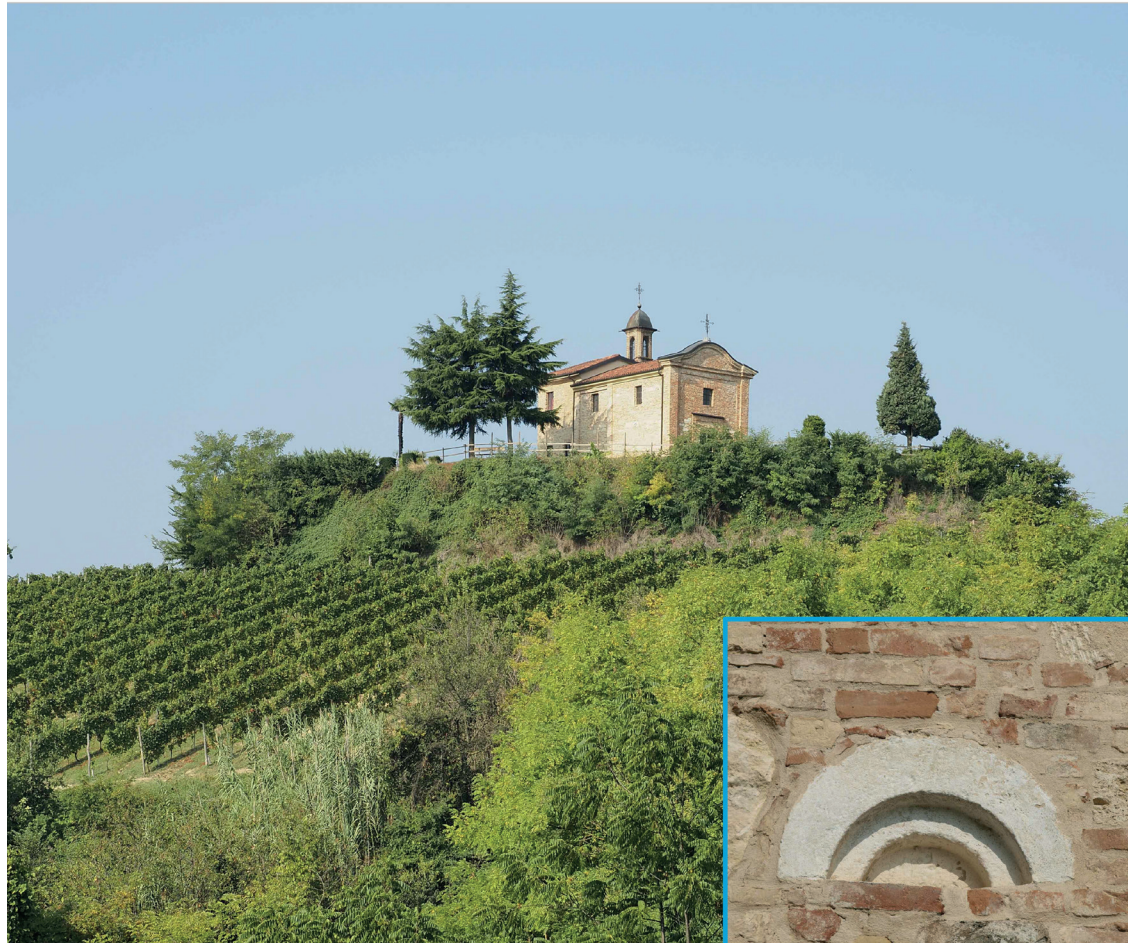
Fig. 8 Cunico (AT), antica località di Ponengo, S. Martino. Panorama e particolare di archivolto relativo all’impianto di XII sec. esposto nei muri di fine Seicento
