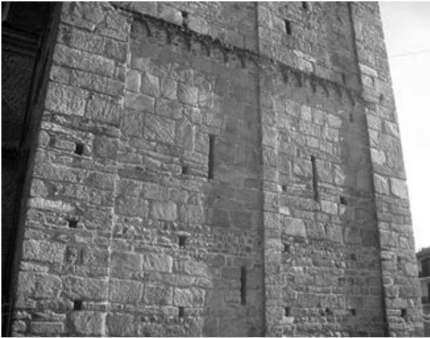
Fig. 8. Torre campanaria, lato nord. In favore di luce si notano la regolarità e le lavorazioni delle superfici.
