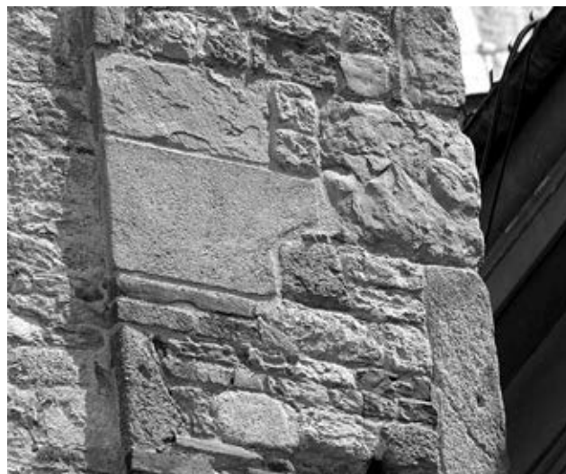
Fig. 6. Torre campanaria, lato ovest. Particolare della tessitura al quinto livello nel contrafforte sud-ovest.
