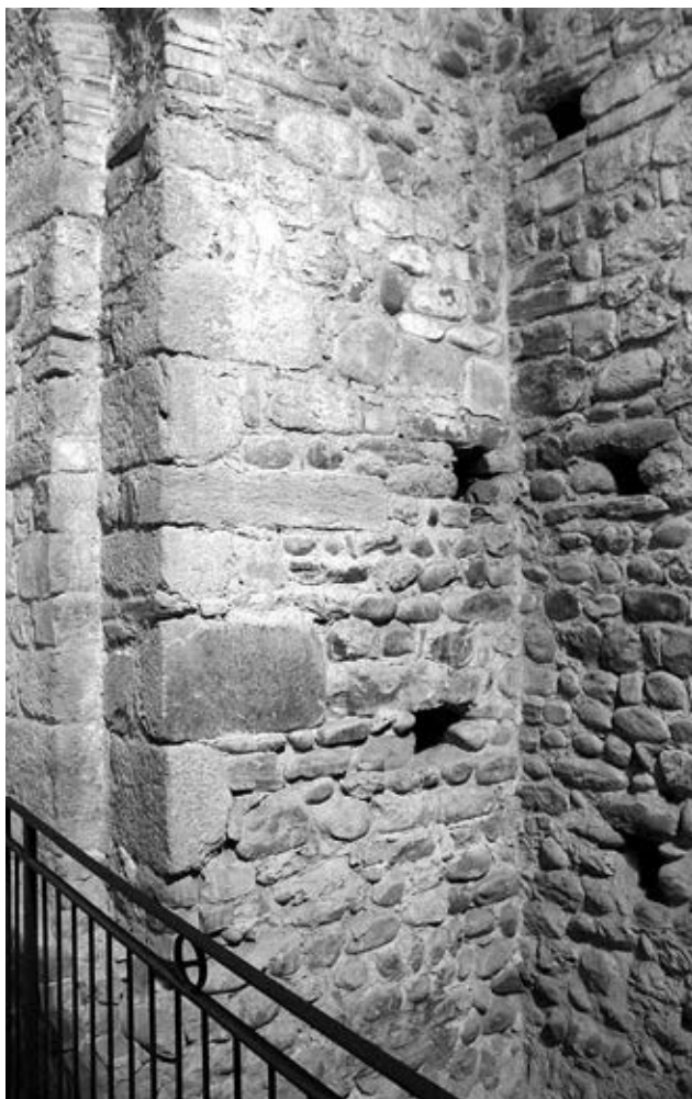
Fig. 4. Torre campanaria. Vista della muratura nell'angolo sud-est in corrispondenza dell'abside in spessore di muro.
