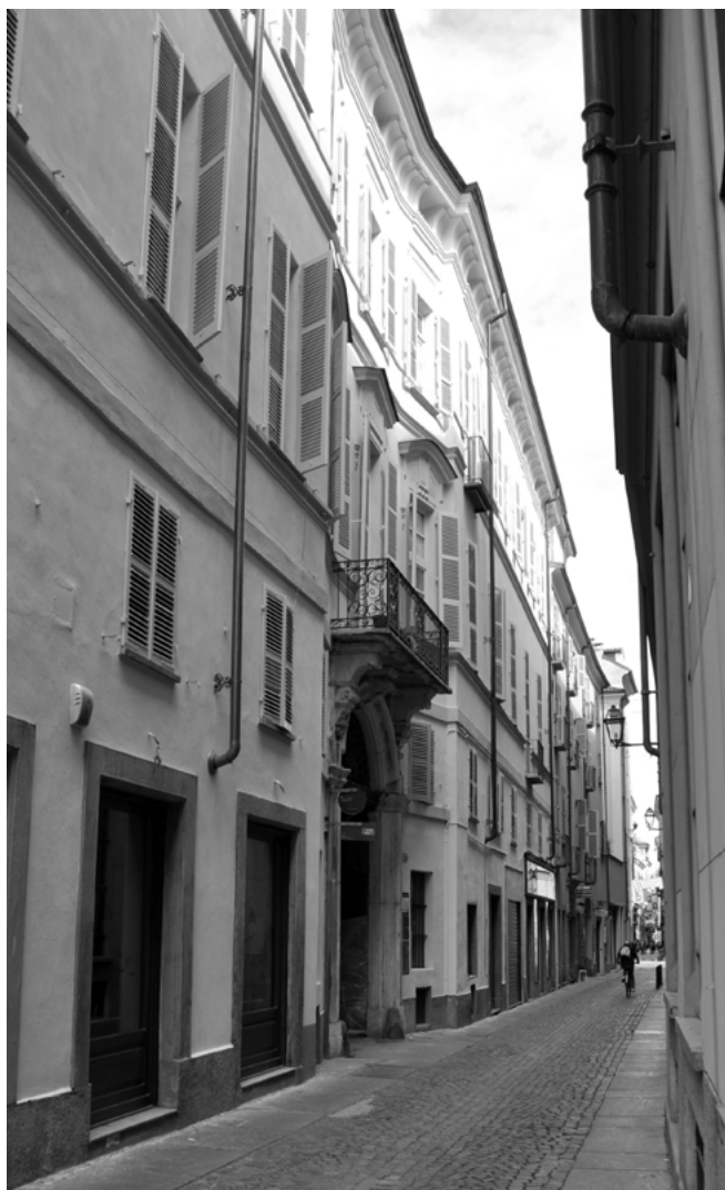
Figura 1. Palazzo d'Arcour, scorcio del fronte su via Barbaroux.
