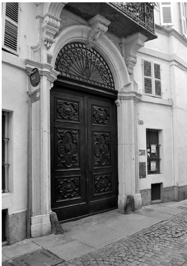
Figura 3. Palazzo d'Arcour, il portale.
