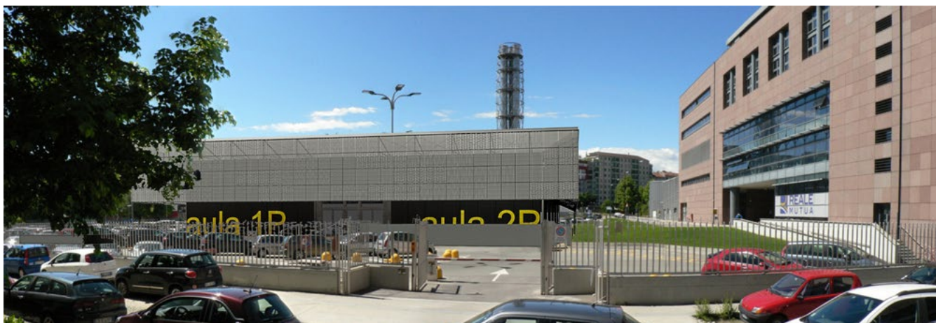
Figura 6. Vista da corso Castelfidardo (fotoinserimento).
