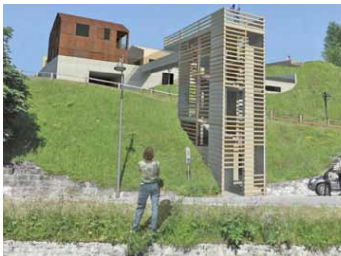
Vista esterna sulla scala
