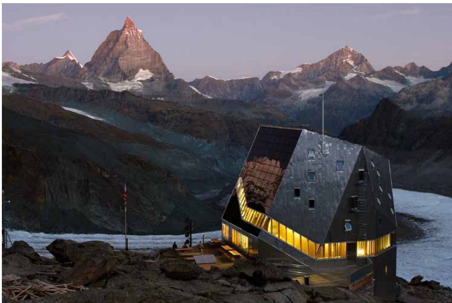
Nuova Monte Rosa Hutte, Svizzera, Bearth & Deplazes, ETH Zurich, 2009 (fotografie di Giorgio Masserano).
