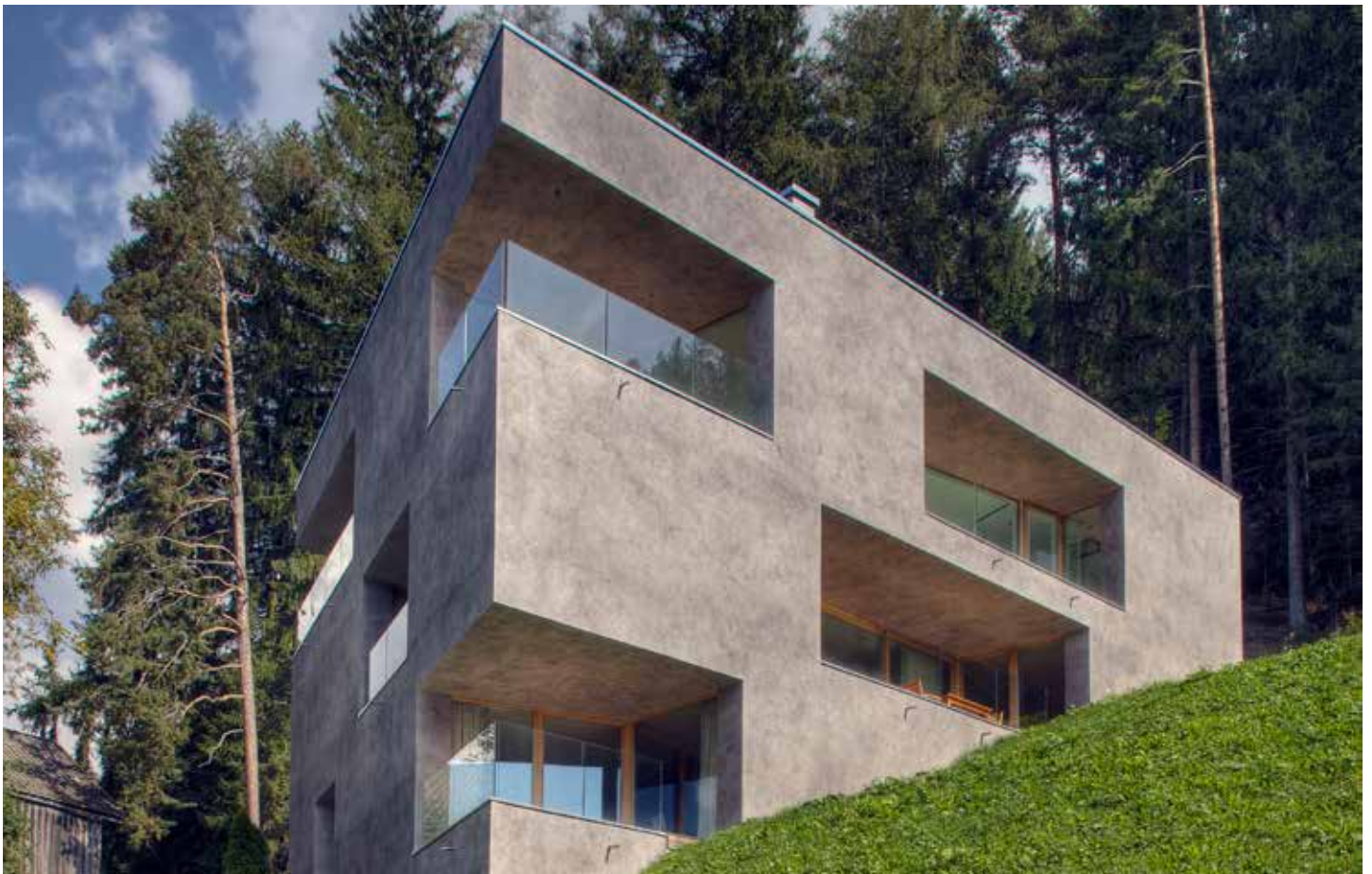
Casa a Sant'Andra, Alto Adige, Bergmeisterwolf, 2002.
