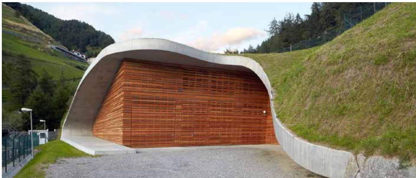
Centrale idroelettrica Punibach a Malles (Bolzano), Monovolume Architecture + Design, 2011, (fotografia di René Riller).
