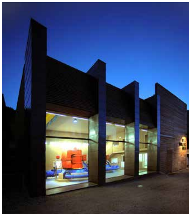
Mini centrale idroelettrica Gadera a San Cassiano (Bolzano), Vudafieri Saverino Partners; 2009.
