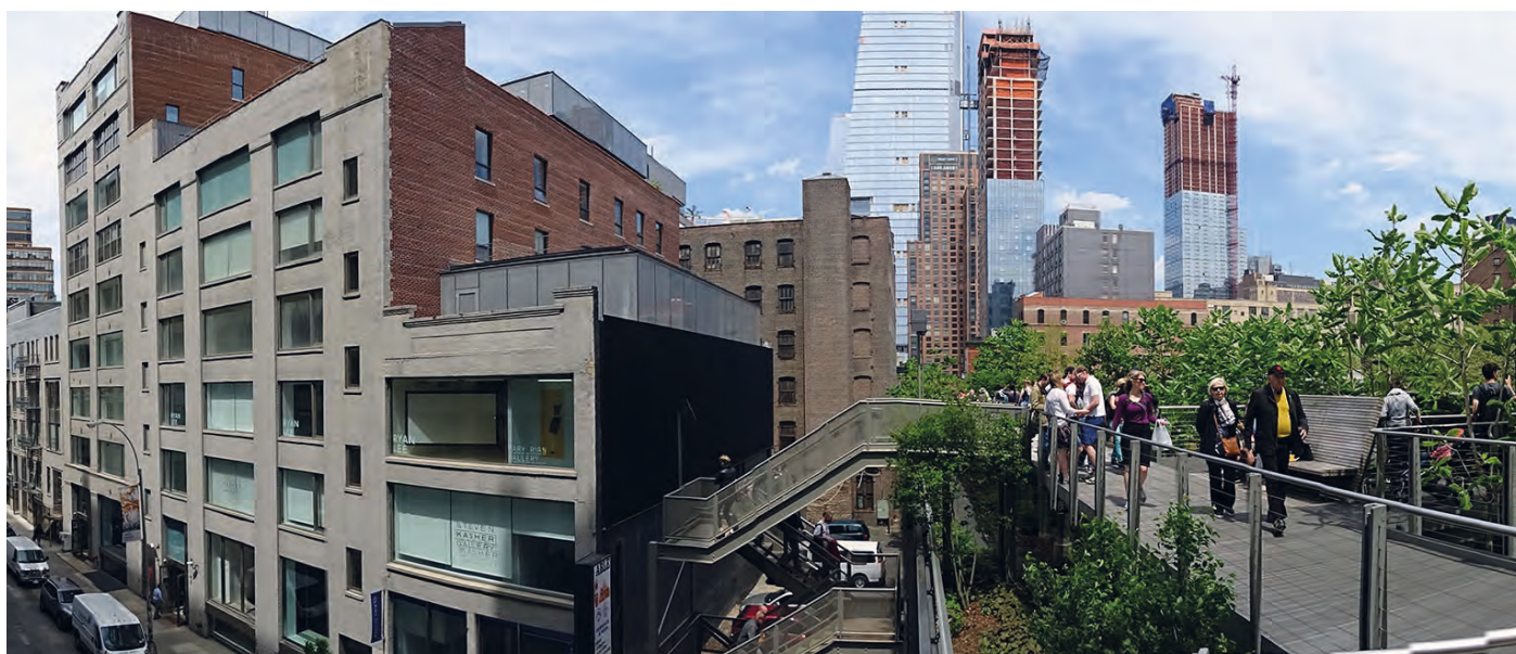
Da sinistra in alto | Aree sedute, Zona servizi localizzati nella porzione centrale, Vista accesso al parco da metà del percorso Crediti: Foto Lucia Baima
