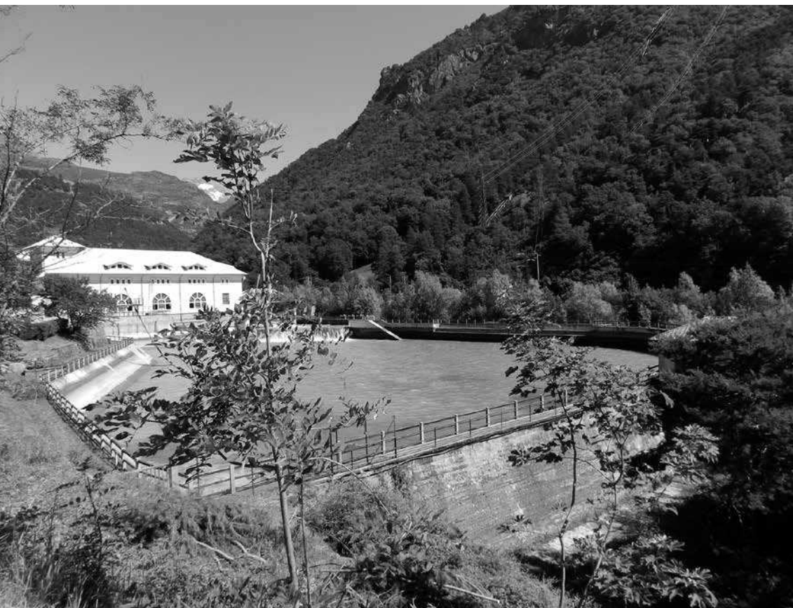
Fig. 5. - Central de Covalou. Antey-Saint-André (Valle de Aosta). Integración de la central y de la cuenca hidrográfica en el paisaje de montaña. Fotografía de Manuela Mattone.
