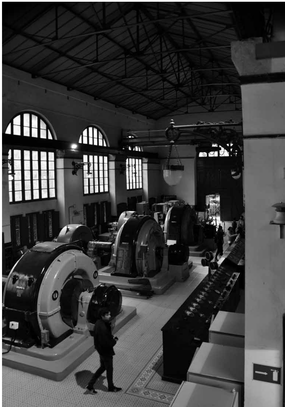
Fig. 1. - Interno della centrale idroelettrica de La Malva. Fotografia di Giorgia Palma, 2016.
