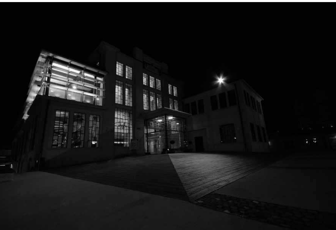
Fig. 11. - Teatro ragazzi. L'ingresso nella sua visione serale. Fonte: Cristina Banfo, archivio servizio edifici municipali Torino.
