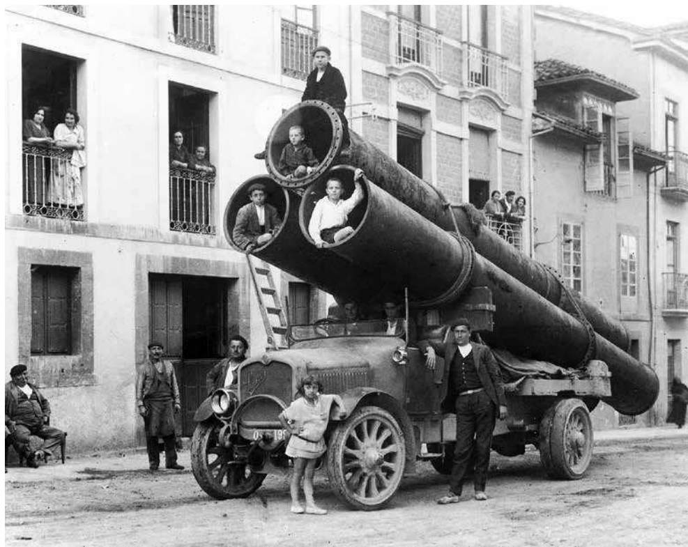
Fig. 6. - Niños jugando con las tuberías forzadas a su paso por la localidad de Grado. Fotografía del Archivo Histórico de Hidroeléctrica del Cantábrico.
