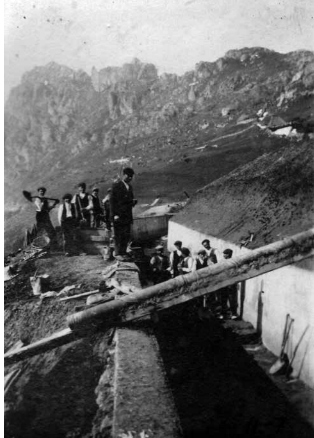
Fig. 4. - Construcción del canal de derivación; Memoria Descriptiva. Saltos de Agua de Somiedo . Oviedo; Hidroeléctrica del Cantábrico, 1917, p. 15.
