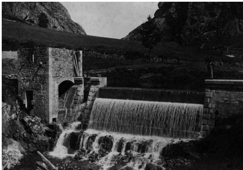
Fig. 3. - Presa del embalse de Valle del Lago; Memoria Descriptiva. Saltos de Agua de Somiedo . Oviedo; Hidroeléctrica del Cantábrico, 1917, p. 12.
