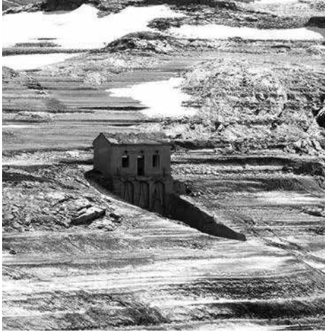
Fig. 3. - El vaciado del embalse de Moncenisio en 2016, que se realiza cada diez años siguiendo el programa de mantenimiento que exige la normativa, desvela de nuevo los edificios sumergidos en los años sesenta a raíz de la construcción de la presa. Fotografía de Elena Vigliocco, 2016.
