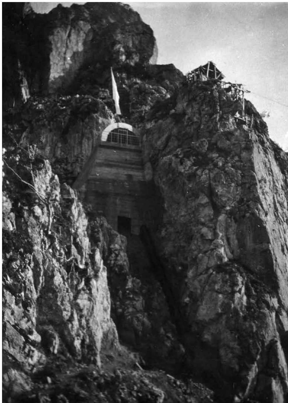
Fig. 5. - Cámara de carga del Salto de la Malva. Memoria Descriptiva. Saltos de Agua de Somiedo . Oviedo; Hidroeléctrica del Cantábrico, 1917, p. 21.
