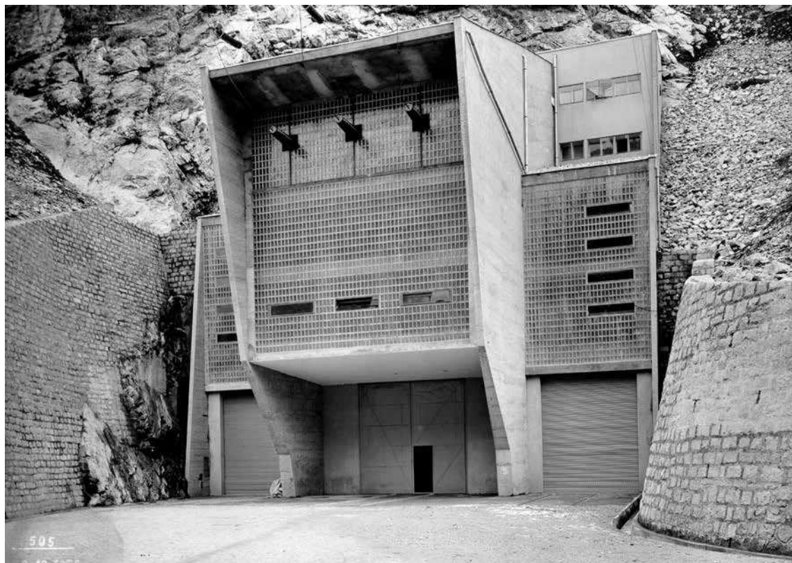
Fig. 10. - Gio Ponti, centrale di Pantano d'Avio, 1955. Fotografia Archivio storico ENEL.
