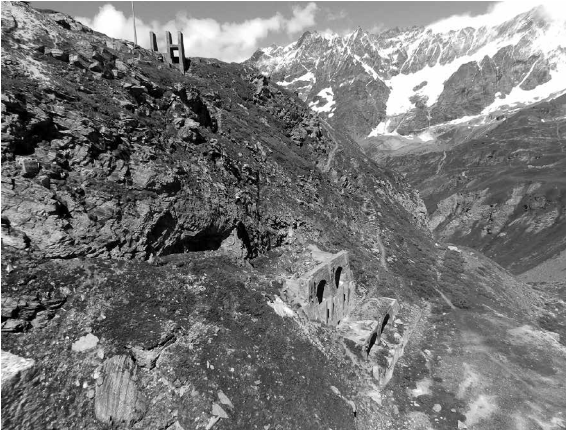
Fig. 8. - Valtournenche (Valle de Aosta). Restos de obras infraestructurales realizadas con motivo de la realización de la presa de Goillet. Estas construcciones, perfectamente engarzadas en la montaña, resultan difícilmente legibles e interpretables hoy en día. Fotografía de Manuela Mattone.
