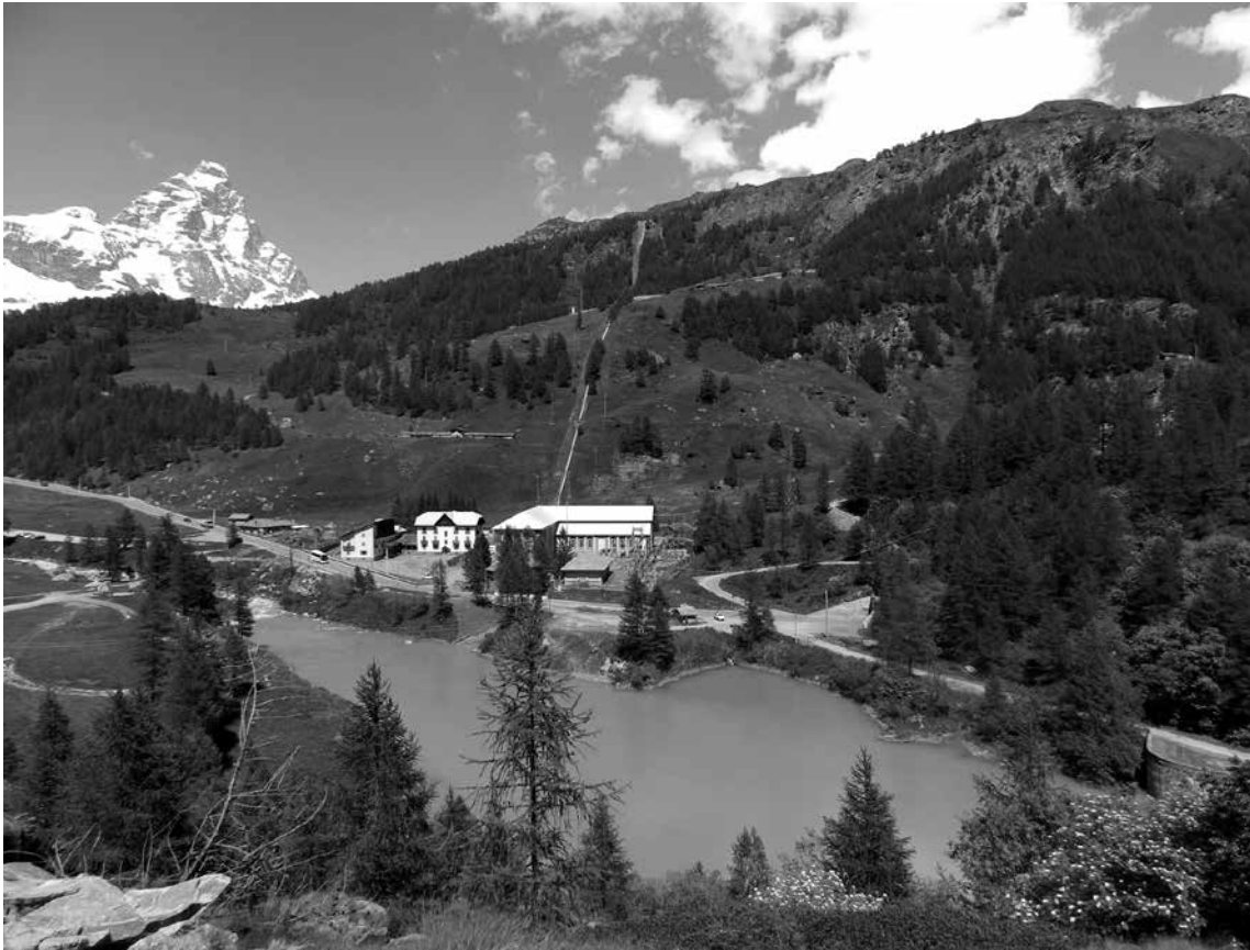
Fig. 4. - Central de Perrères. Valtournenche (Valle de Aosta). Integración de la central y de los conductos forzados en el paisaje de montaña. Fotografía de Manuela Mattone.
