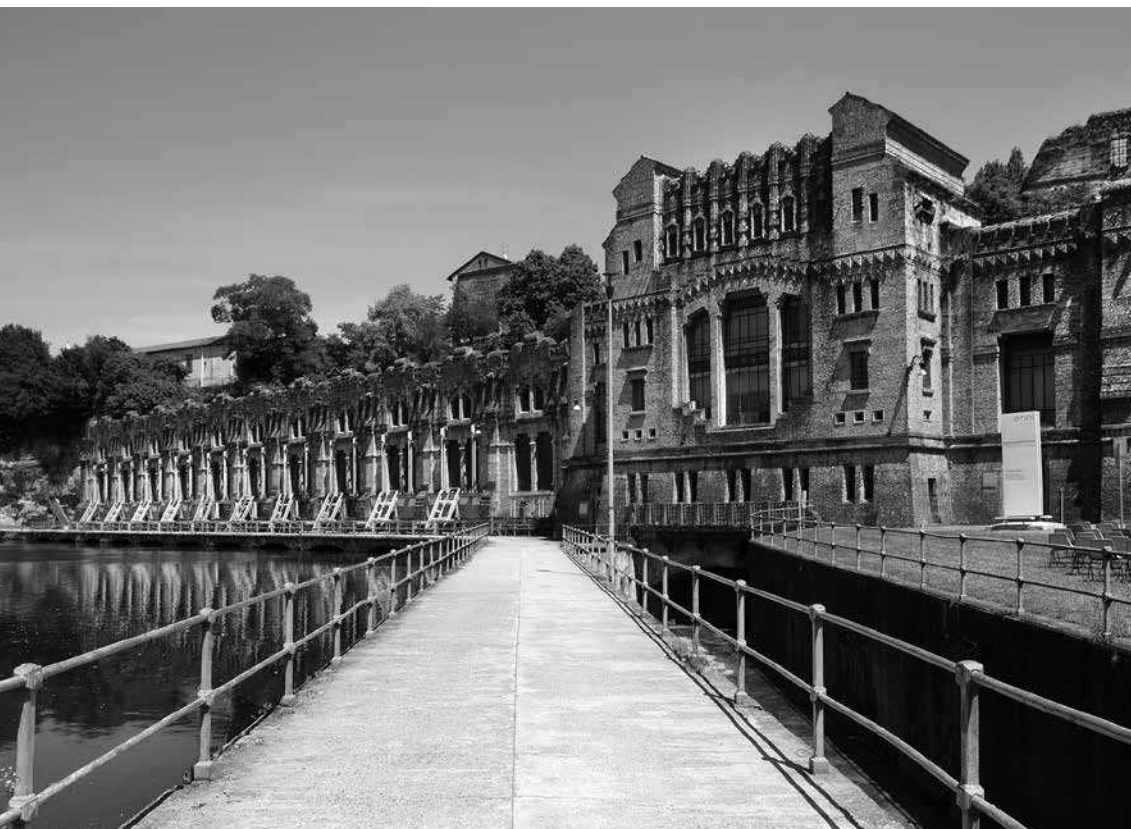
Fig. 13. - Las centrales del Parco Adda Nord: Taccani. Fotografías Studio Publica, 2017.
