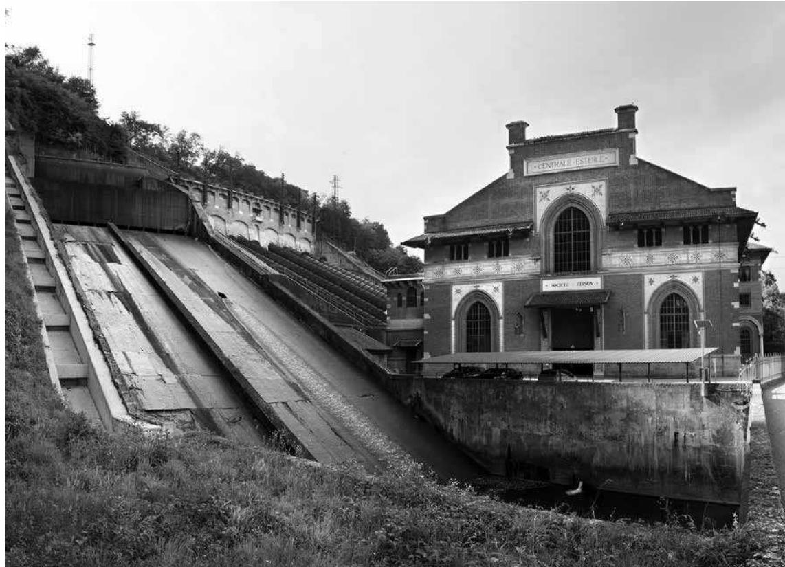
Fig. 1. - Central hidroeléctrica Esterle, de Porto d'Adda. Fotografía de Studio Publica, 2017.
