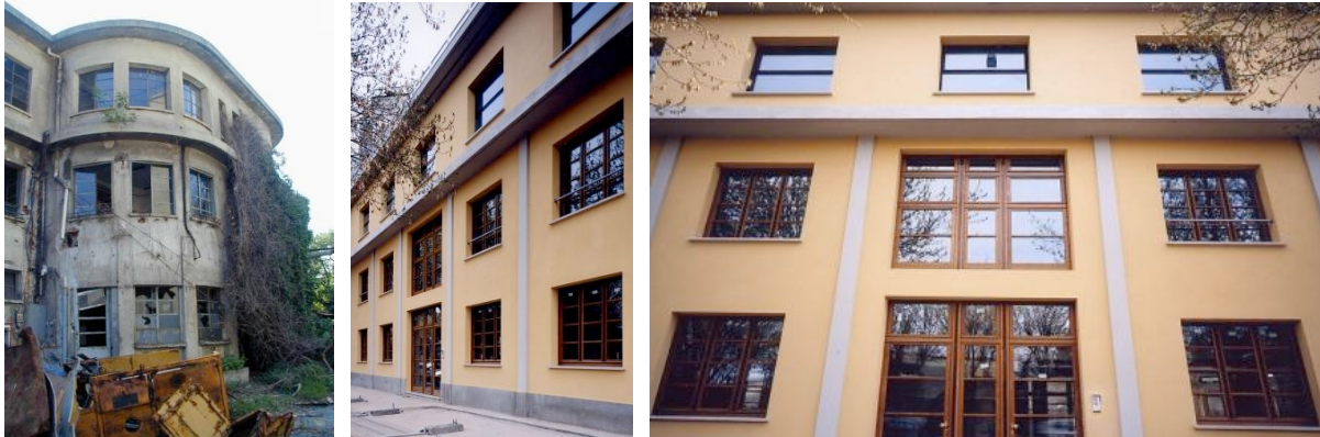
Figura 3. Da sinistra. La palazzina 37 prima dell'intervento di recupero; due immagini della palazzina 37 dopo: il fronte strada. Foto: Vigliocco, 2000; Biamino, 2002.
