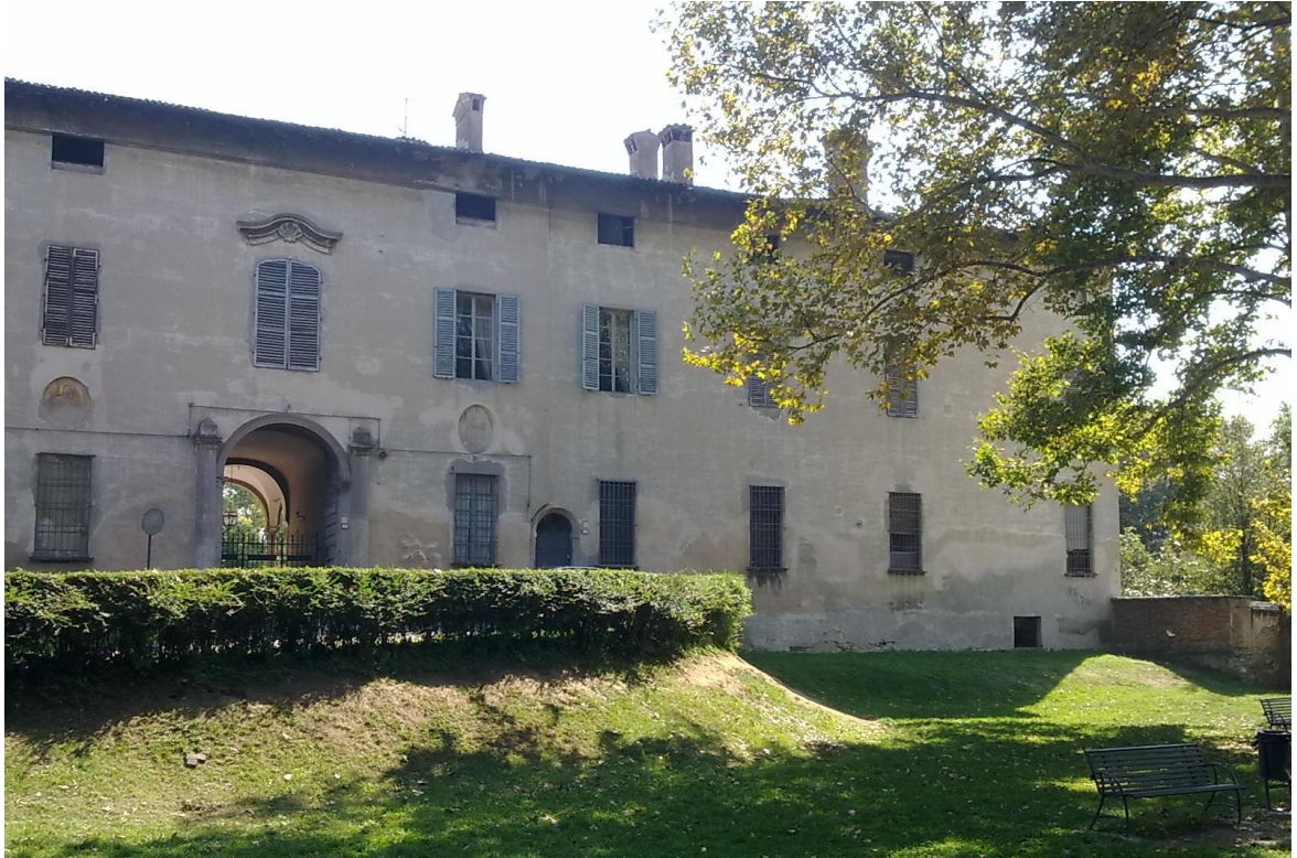
105. Facciata del palazzo residenziale dei marchesi Pallavicino, parzialmente trasformato nei secoli successivi.
