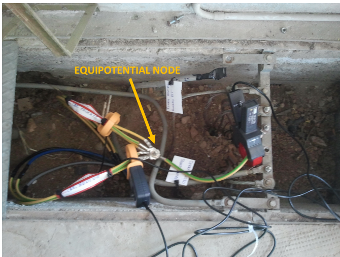
Fig. 4. Equipotential node in the MV/LV substations
