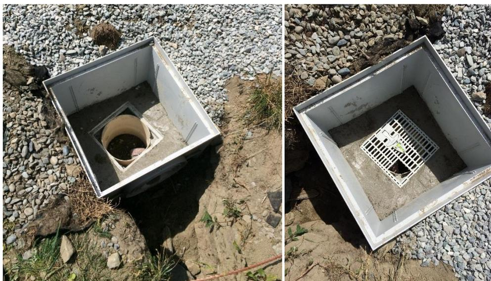
Figura 21 - Pozzetto di alloggiamento del pluviometro interrato
