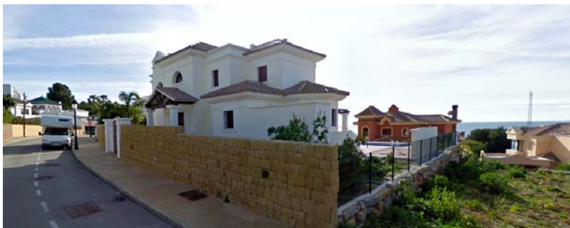
Figure 5. Urbanización Puerto de Estepona
