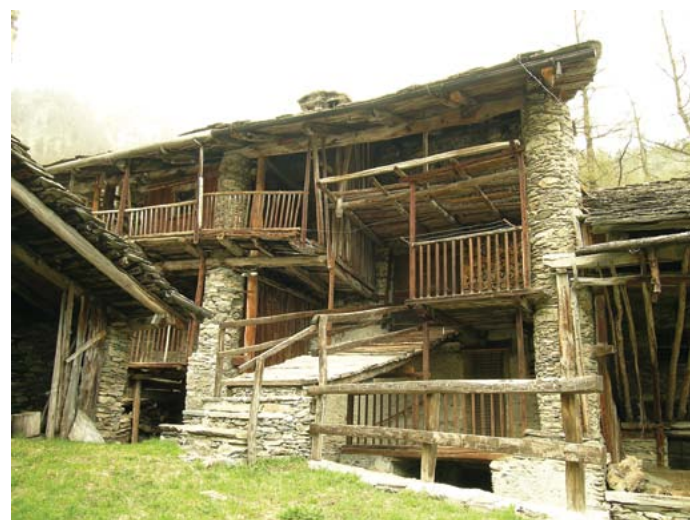
[Fig. 6 - edificio tradizionale con logge e spazi aperti-coperti sul fronte - Elva (CN) - foto Andrea Bocco]
