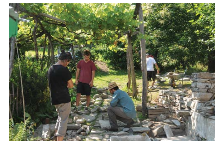
[Fig. 21 - workshop organizzato dalla Associazione Canova sulla costruzione di case in pietra - Crevoladossola (VB) - foto Francesco Stassi]
