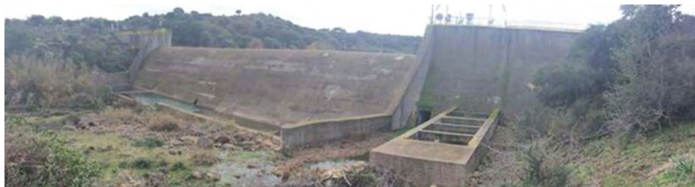
Foto 1 Situazione diga Fiumara pre-esistente, montanti su coronamento in parte piegati, fune provvisoria pericolosa
