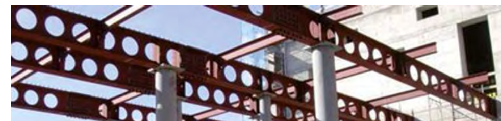
Travi Alveolari in fase di cantiere
