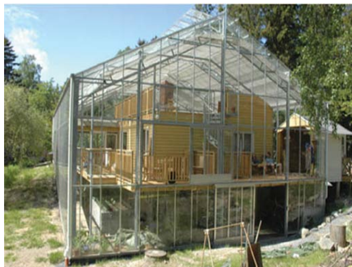
[Fig. 13 - "Naturhuset" a Vänersborg, Svezia, arch. Bengt Warne - la serra attorno all'edificio forma una zona intermedia di temperatura tra l'ambiente interno e quello esterno, grazie agli apporti passivi]
