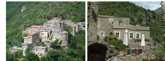
[Figg. 41-42 - 1991/1998 - Colletta di Castelbianco, Castelbianco, valle Pennavaira (SV), 300 m s.l.m. Ristrutturazione e rifunzionalizzazione dell'intero borgo ad opera di un'unica società. Progettista: Giancarlo de Carlo. Elementi caratterizzanti:
