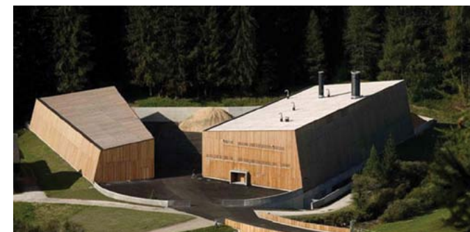
[Fig. 2 - Sigfried Delueg, Centrale di teleriscaldamento a Sesto (BZ) - fonte: www.fhs.bz]
