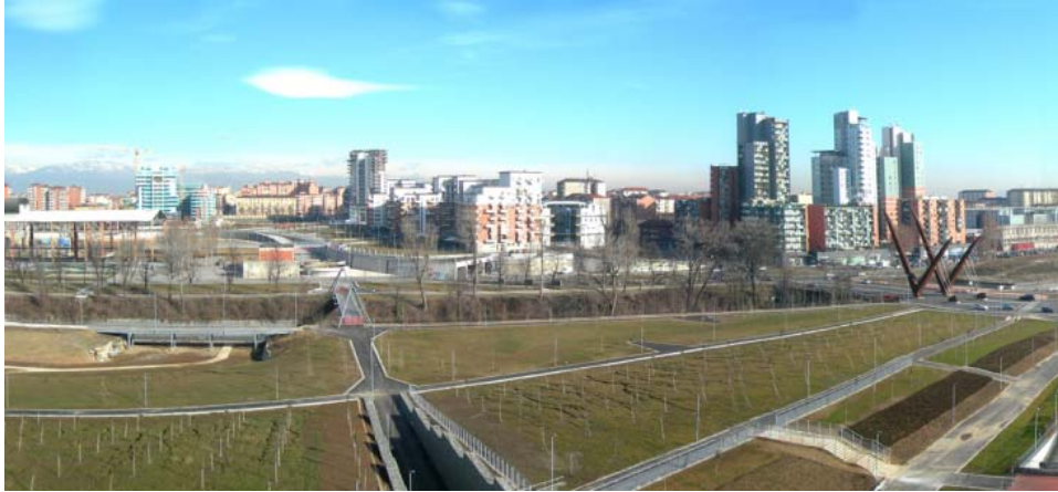
Figura 1 - Quartiere Dora, Spina 3, vista panoramica verso nord
