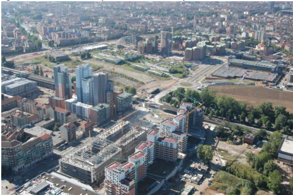
Figura 2 - Quartiere Dora, Spina 3, vista area complessiva
