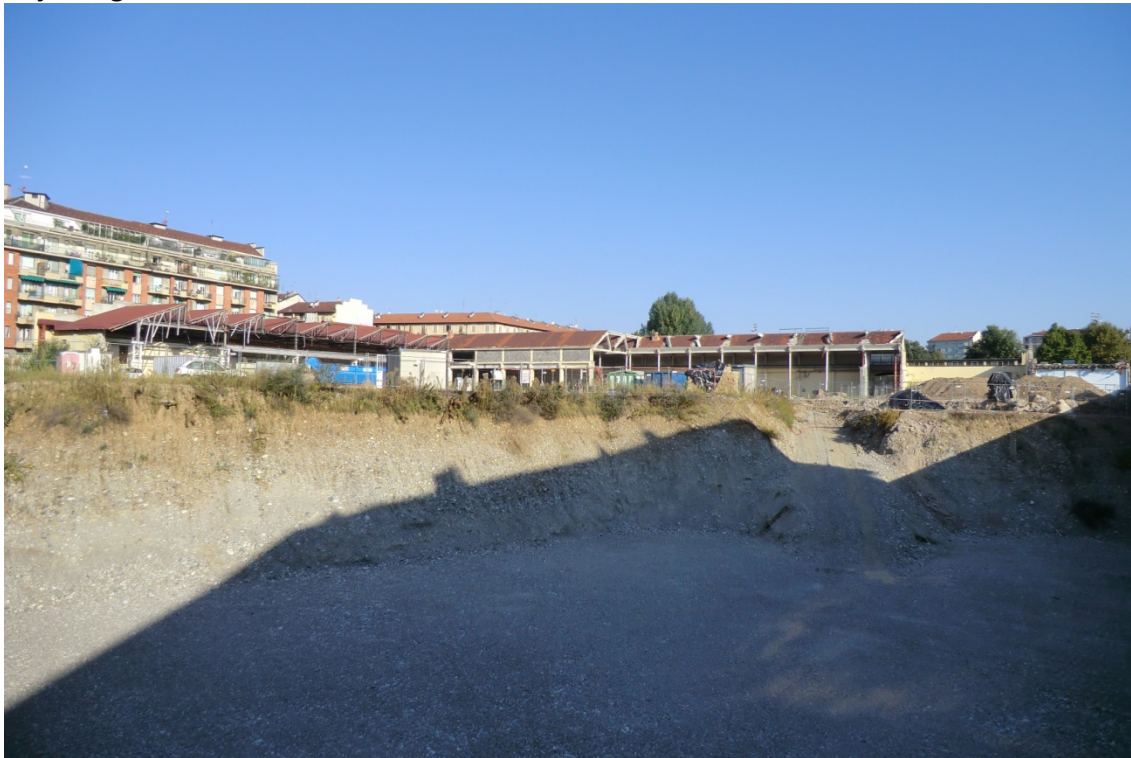
Figura 2. Vista della palazzina uffici e del muro perimetrale della Diatto – Snia Viscosa da via Frejus angolo via Cesana
