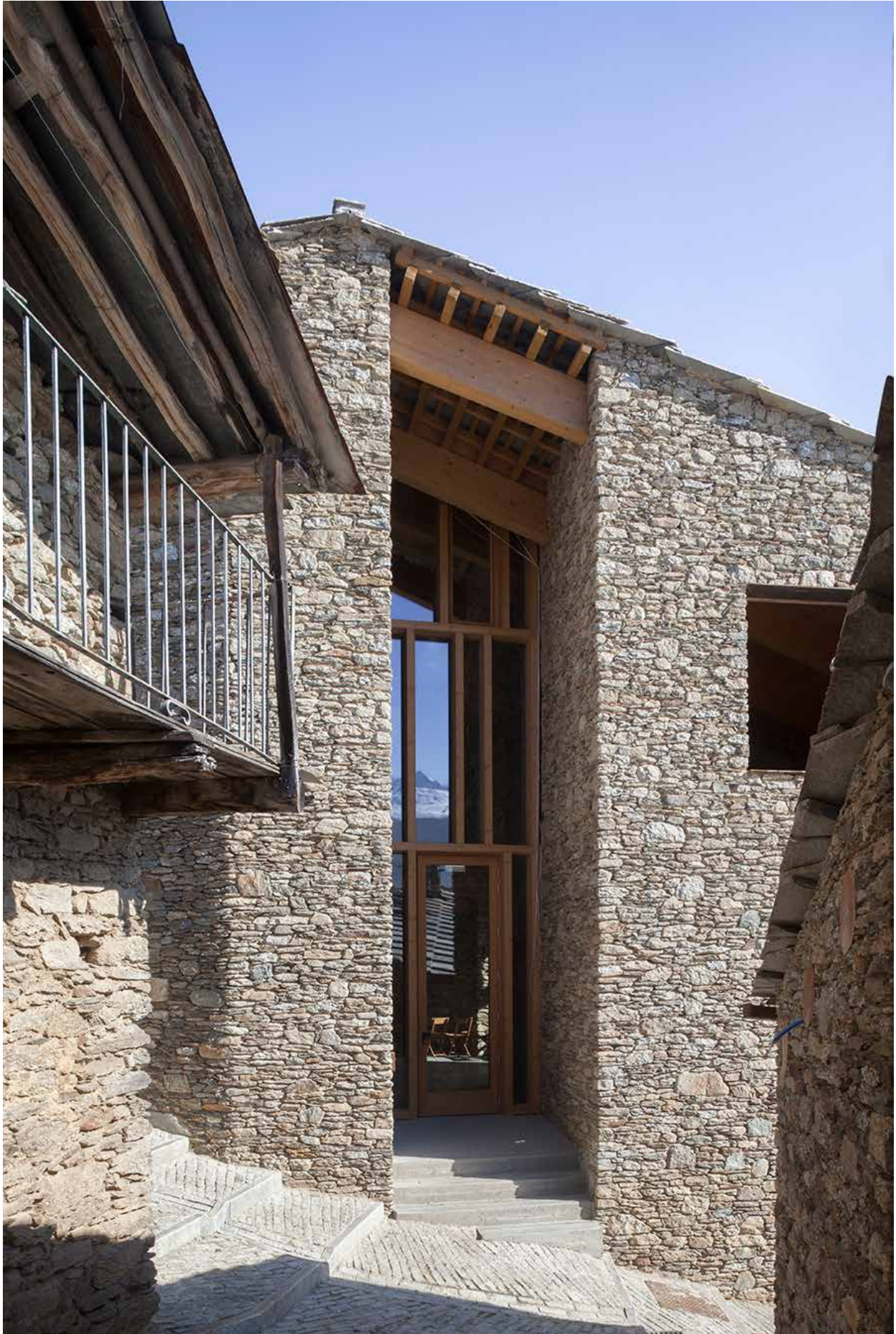
L'asse d'ingresso del centro che attraversa e distribuisce tutto l'edificio (fotografia di Laura Cantarella).
