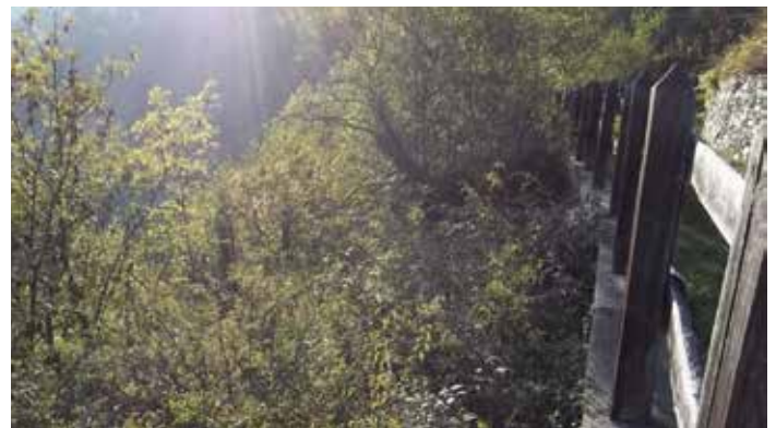
Tratti da ripulire dalla vegetazione invadente e aree di rifacimento muretti a secco.
