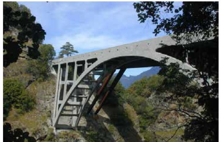
A. Sarrasin, pont du Gueuroz (Svizzera, Vernayaz, Valais).
