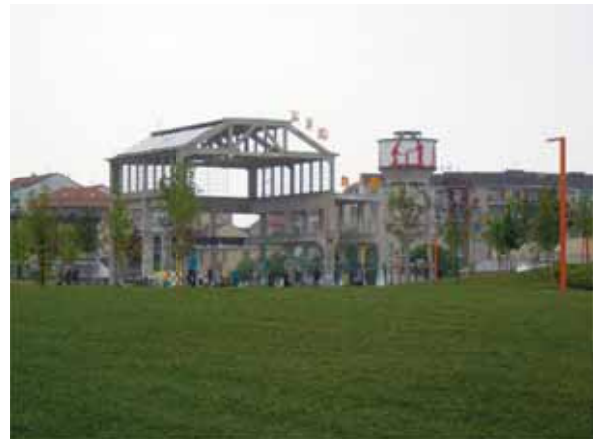
Fig. 2. Parco Aurelio Peccei (Spina 4), Torino, al termine della costruzione, maggio 2015.
