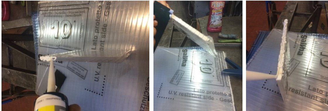
Figura 8 Sigillatura con silicone acetico degli alveoli di un pannello in policarbonato
