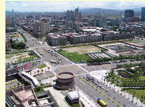
車站站區土地利用(案例)－板橋縣民大道通車現況
