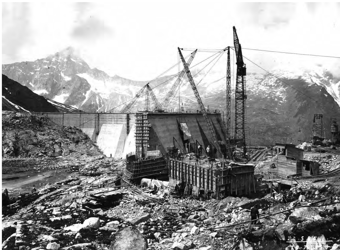
Diga Venerocolo in costruzione (1958).
