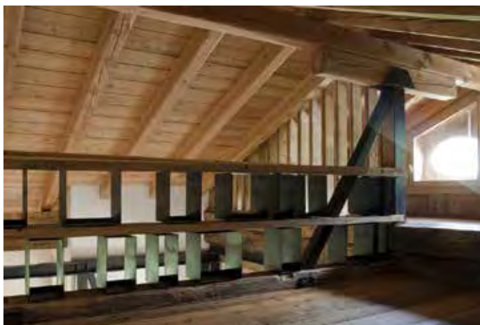
Bardonecchia, Grange Horres. Recupero di un vecchio fienile presso Grange Horres, architetto Anna Eula Matteoli.
