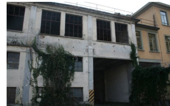
Prospetto interno al cortile
