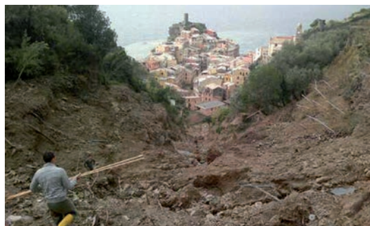
Figura 2.b (a destra) Il versante montano sconnesso alle spalle di Vernazza
