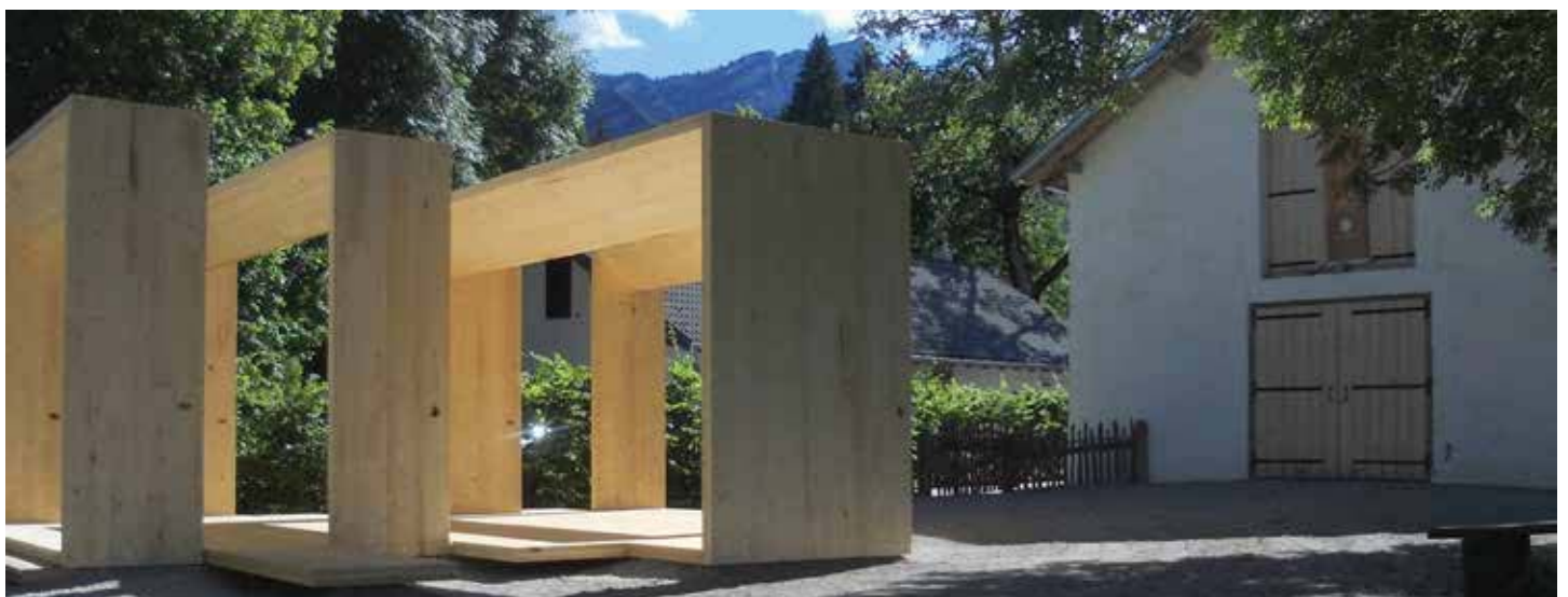
Realizzazione del prototipo per la zona Malga Costa, costruito in pannelli XLam con legno di larice del Trentino (fotografie di Enrico Casale).
