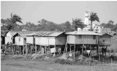
Figura 1.7: Case su palafitte per evitare i danni dalle inondazioni, Bangladesch 2009, (Fonte: A. Bird).
