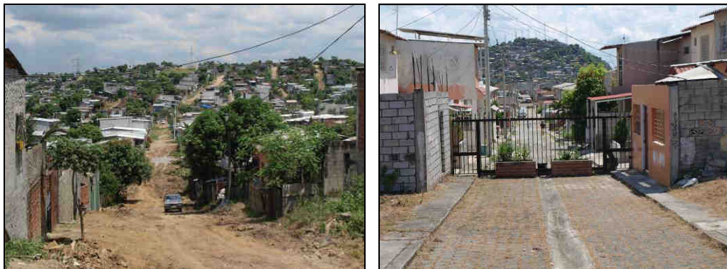
Figura 3.22 – Guayaquil, A sinistra Bastion Popular barrio, 2012. Strade non asfaltate dove emerge l'assenza di un canale di drenaggio; A destra Alborada barrio, 2012. Strada ricoperta da pietre dove si snoda un canale di scolo centrale (Foto di E. Ponte)
