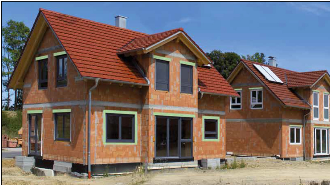
Figura 5.54. Klimatrave in un cantiere
