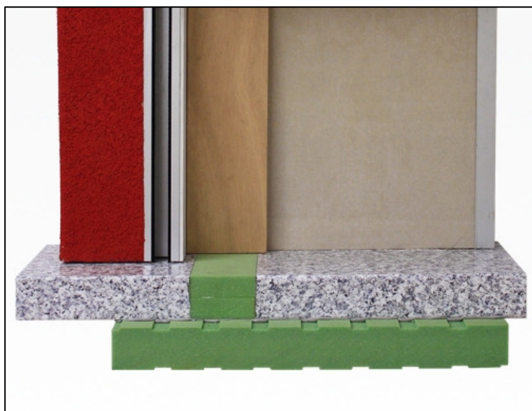
Figura 5.51. Dettaglio di soglia con taglio termico
