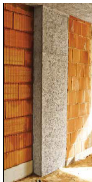
Figura 5.57. Esempio applicativo con rivestimento di un pilastro
