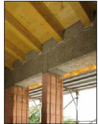
Figura 5.60. Esempio applicativo con rivestimento di una trave
