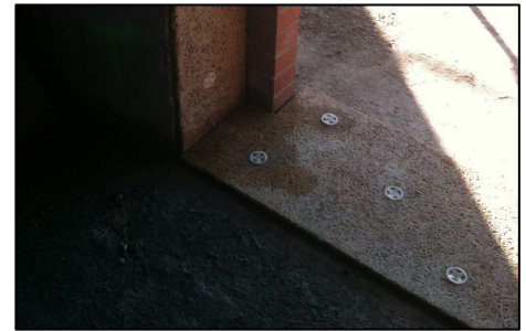
Figura 5.3. Isolamento soglia serramento
