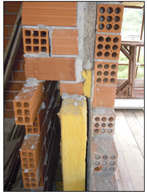
Figura 5.6. Isolamento in intercapedine
