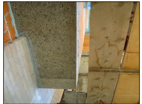
Figura 5.8. Coibentazione aggetto esterno (intradosso)
