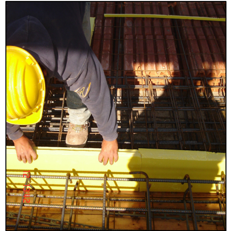
Figura 5.2. Posa dell'isolante per copertura orizzontale
