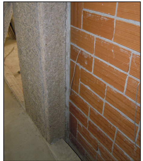
Figura 5.7. Eliminazione del ponte termico del pilastro
