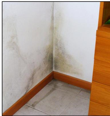
Figura 2.5. Formazione di muffa in un ambiente interno
