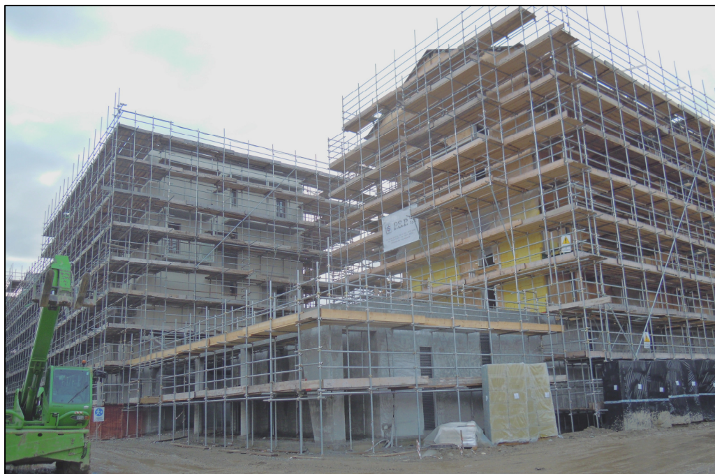
Figura 5.13. Inquadramento generale di cantiere
