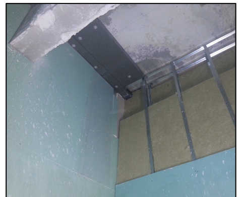
Figura 5.20. Intradosso coibentato per minimizzare il ponte termico del cornicione
