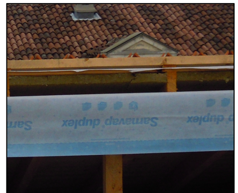
Figura 5.24. Coibentazione della falda inclinata della copertura
