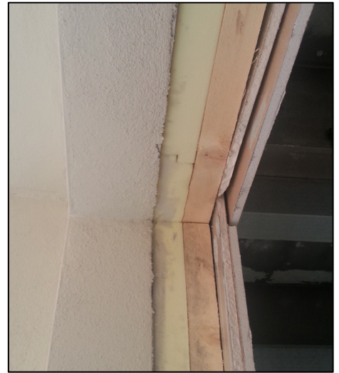
Figura 5.18. Isolamento a cappotto interno
