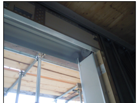
Figura 5.15. Cassonetto coibentato per sistema oscurante avvolgibile
