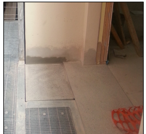
Figura 5.19. Ponte termico della soglia d'ingresso
