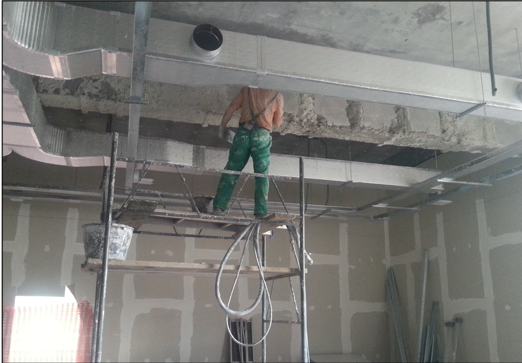
Figura 5.17. Inquadramento generale di cantiere
