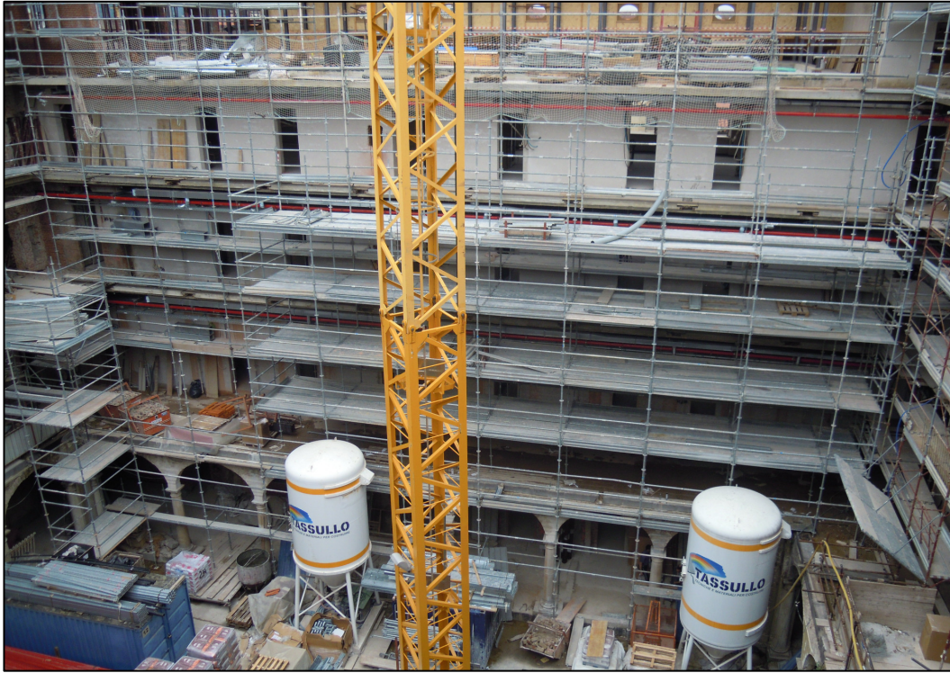
Figura 5.21. Inquadramento generale di cantiere
