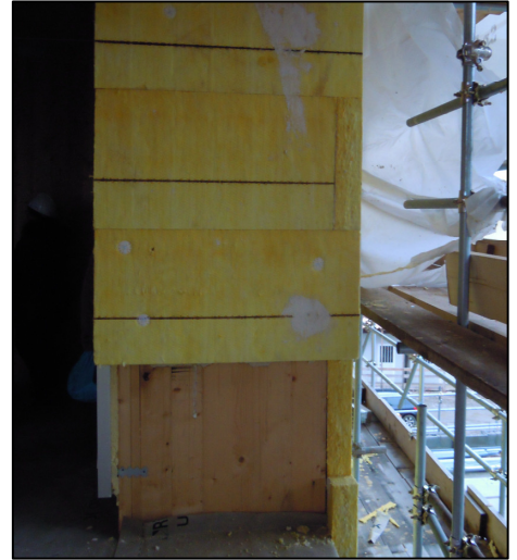
Figura 5.14. Rivestimento a cappotto esterno
