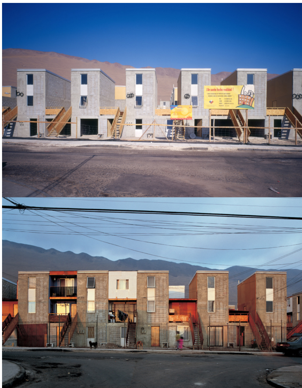
Figura 3.8: Il processo evolutivo posto in essere dai progetti ELEMENTAL: nella parte alta dell'immagine gli edifici consegnati agli abitanti della Quinta Monroy, nella parte bassa, gli edifici come si presentano dopo gli ampliamenti da parte degli utenti (fonte: http://www.elementalchile.cl/proyecto/quinta-monroy/ ).
