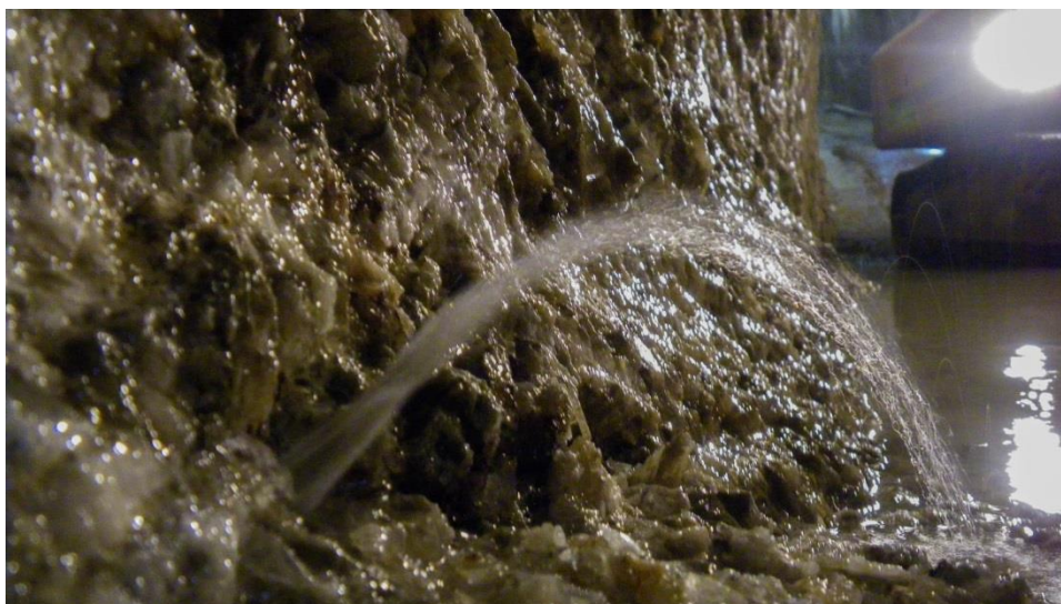
Figura 146: Venute idriche da microfratturazione
