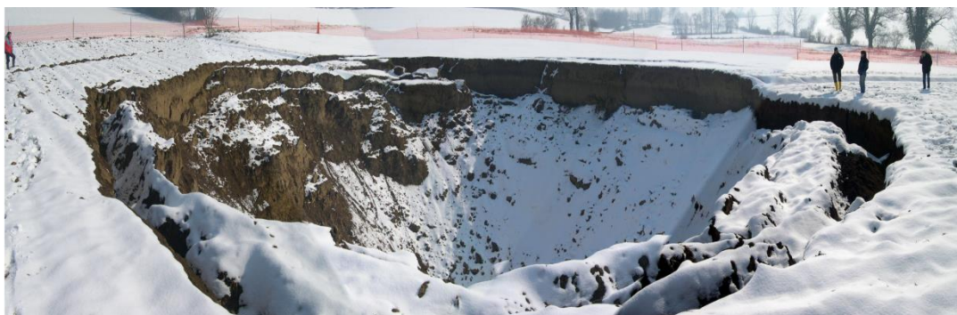
Figura 74. Vista S del sinkhole
