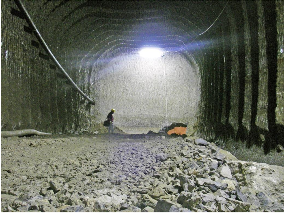
Figura 71: Punto di inrush sul fronte di scavo
