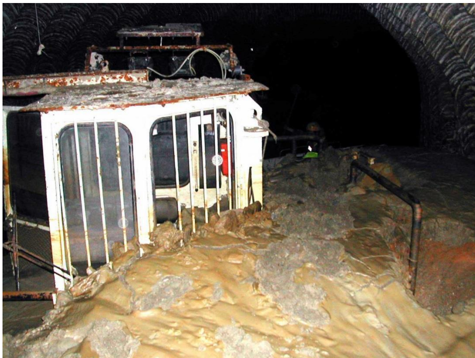
Figura 72: Il fango ha sommerso i mezzi di scavo
