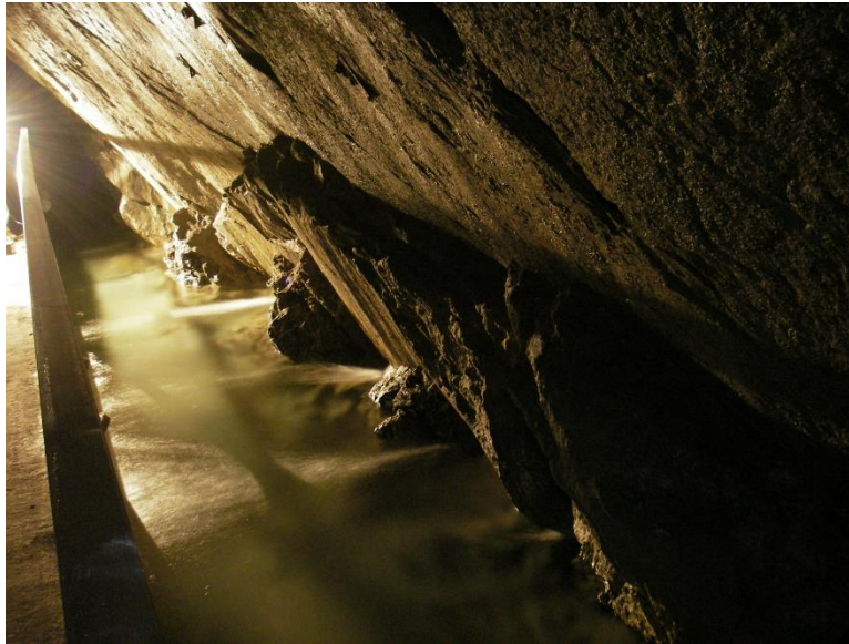
Figura 194: Galleria di captazione della Sorgente di Tenda
