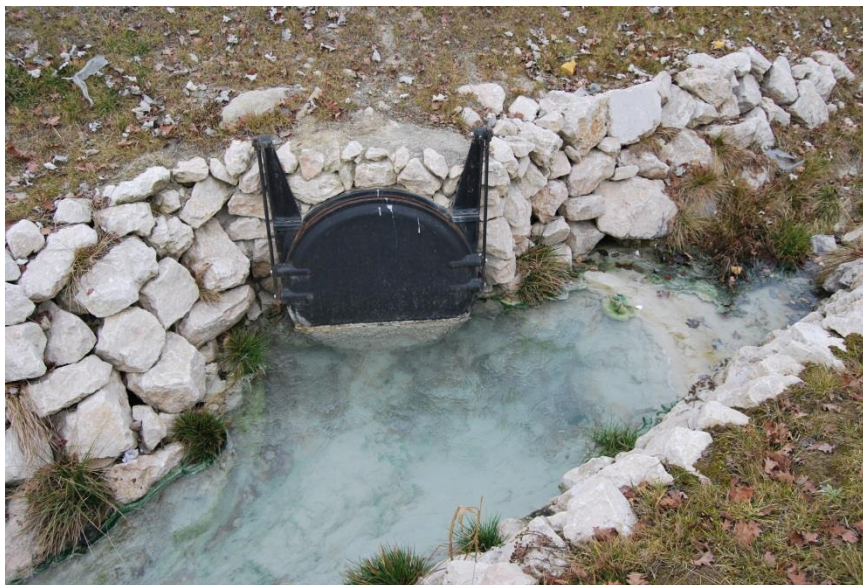
Figura 189: Scarico presso l'imbocco Est
