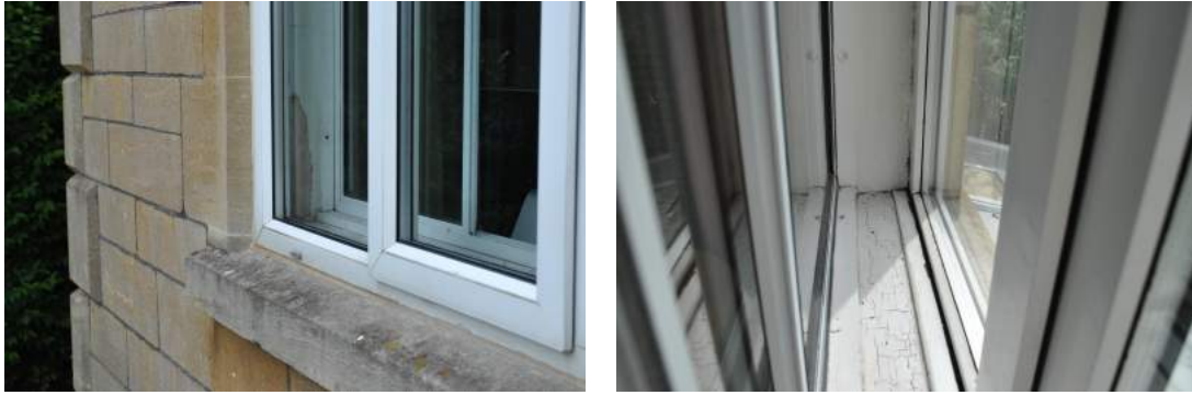
Figura 1.4: Fotografie di un doppio infisso presente in un'abitazione inglese (a sinistra, vista esterna; a destra, vista dell'intercapedine tra i due infissi) (A.R. Bertorello, 26 luglio 2013)
