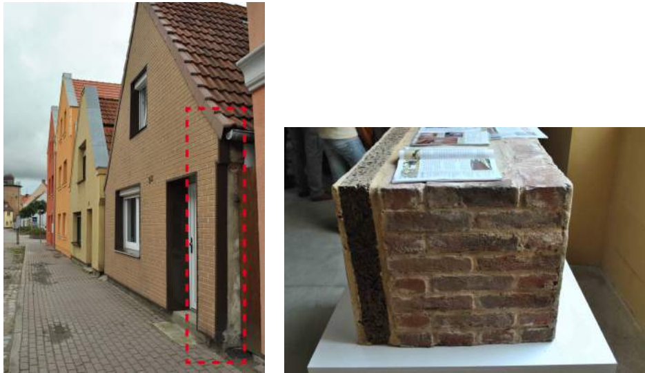
Figura 2.1: intervento di isolamento dall'esterno di edificio esistente in cui viene evidenziato l'isolamento esterno applicato sulla facciata principale dell'abitazione (Germania del Nord) (A.R. Bertorello, 27 agosto 2010); a destra: modello al vero della chiusura verticale della zona espositiva di Nova Civitas – Fondazione Pistoletto (Biella) isolata dall'interno con lastre di sughero (A.R. Bertorello, 28 ottobre 2011)
