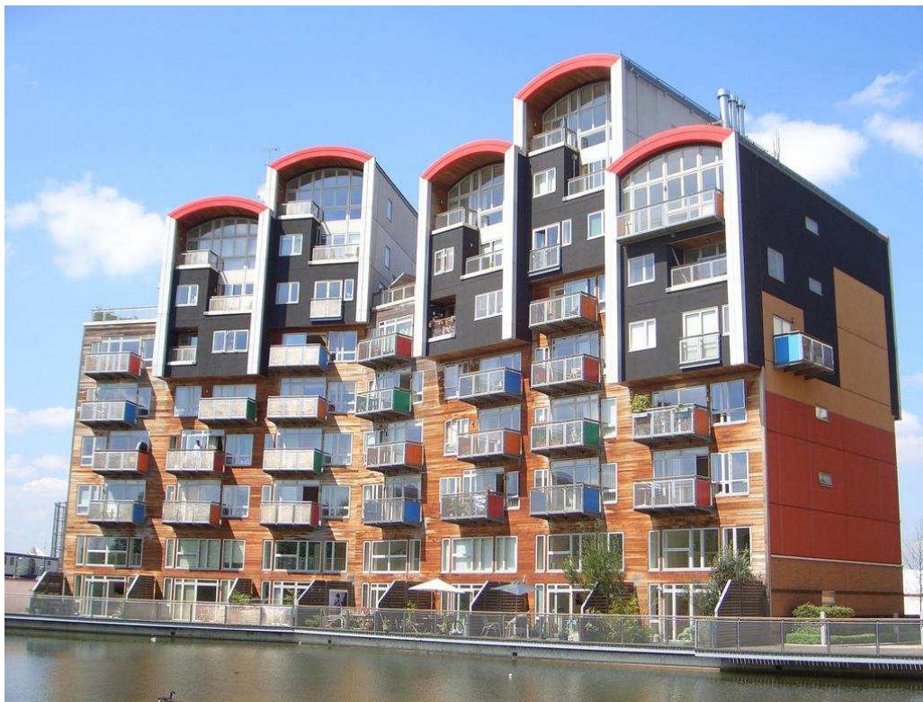
Figura 15. La tipologia prevalente è quella di edifici condominiali a sei o otto piani fuori terra
