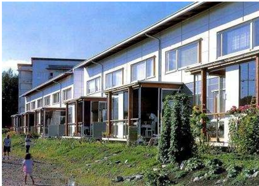
Figura 21. Le facciate a sud delle abitazioni hanno ampie superfici vetrate per aumentare i guadagni solari
