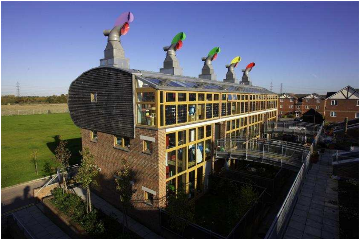
Figura 9. Le superfici esposte a sud sono ampiamente vetrate in modo da ottenere i massimi guadagni solari possibili
