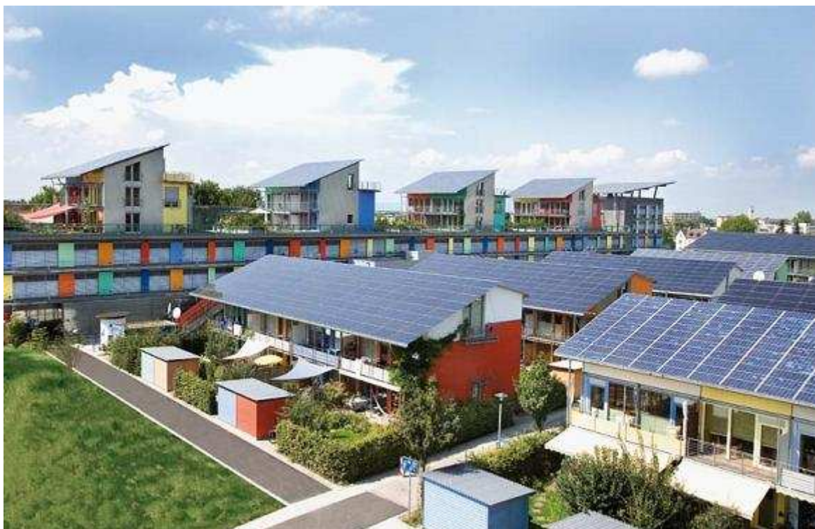
Figura 7. Le coperture degli edifici sono studiate per avere la massima superficie esposta a sud
