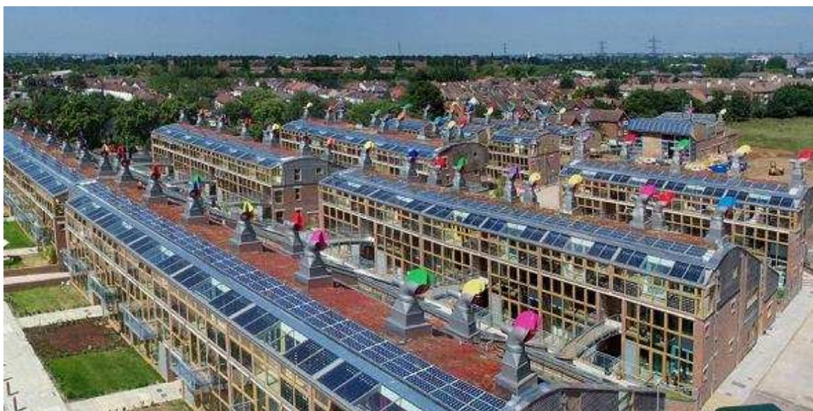
Figura 8. Gli edifici sono progettati in modo da avere la massima superficie possibile esposta a sud
