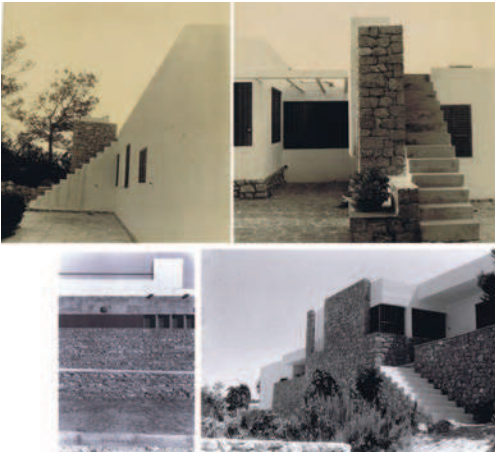
Fig. 4. E. Donato, Casa Mangrané, vistas y detalles
