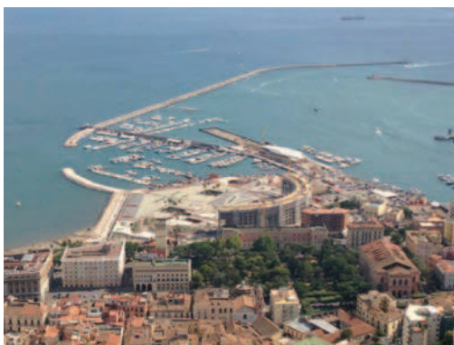
Veduta aerea del cantiere di Piazza della Libertà (settembre 2013): il Crescent in costruzione e sullo sfondo la stazione marittima.
