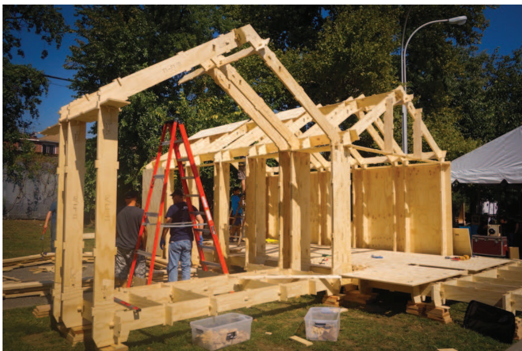
Figura 4.21: Il padiglione realizzato per la World Maker Faire 2013 a New York. La struttura è stata montata in un giorno e mezzo da utenti non esperti e utilizzata dal pubblico durante tutta la fiera (fonte: http://www.wikihouse.cc/ ).
