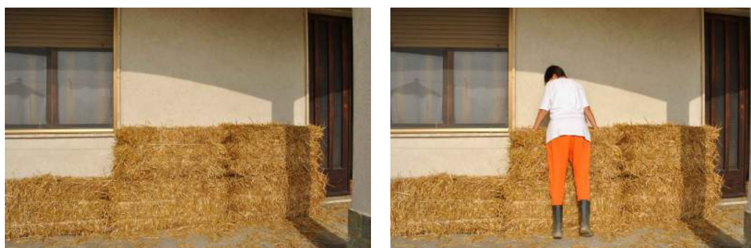
Figura 6.9: Disposizione delle balle in foglio non sfalsate (foto A.R. Bertorello, 26.10.13)
