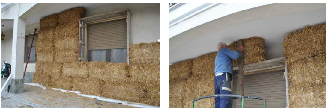
Figura 6.16: Fasi di costruzione dell'isolamento in paglia (A.R. Bertorello, 28.12.13)
