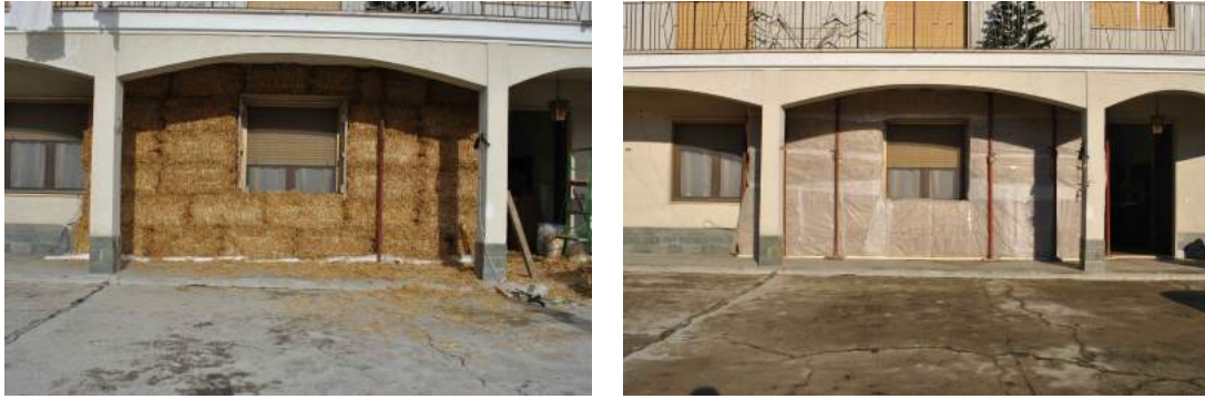
Figura 6.17: Isolamento in paglia prima della collocazione del tessuto non tessuto e intervento di isolamento terminato (A.R. Bertorello, 29.12.13)
