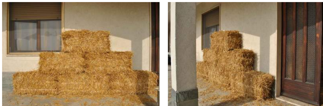
Figura 6.8: Disposizione delle balle "in foglio" sfalsata (foto A.R. Bertorello, 26.10.13)
