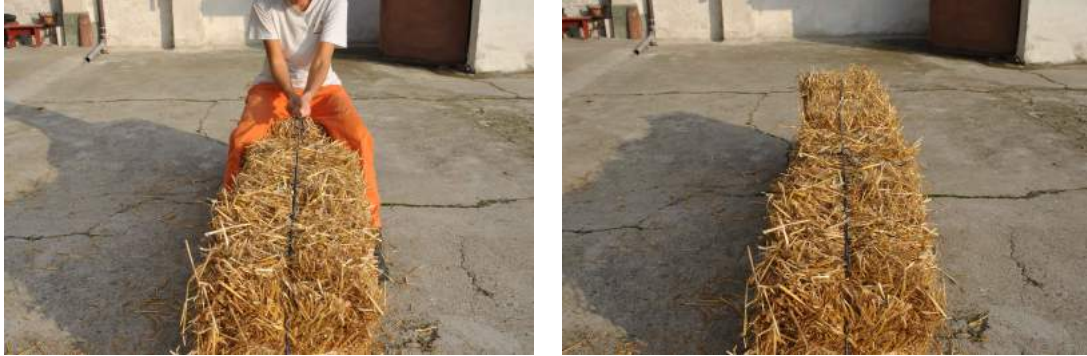
Figura 6.12: Tiraggio della corda per compattare le balle e due balle legate superiormente (foto A.R. Bertorello, 29.10.13)
