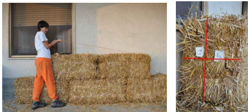
Figura 6.13: Passaggio della corda nella parte superiore e legature della balla: superiore (La1) e laterale (La2) (foto A.R. Bertorello, 29.10.13)
