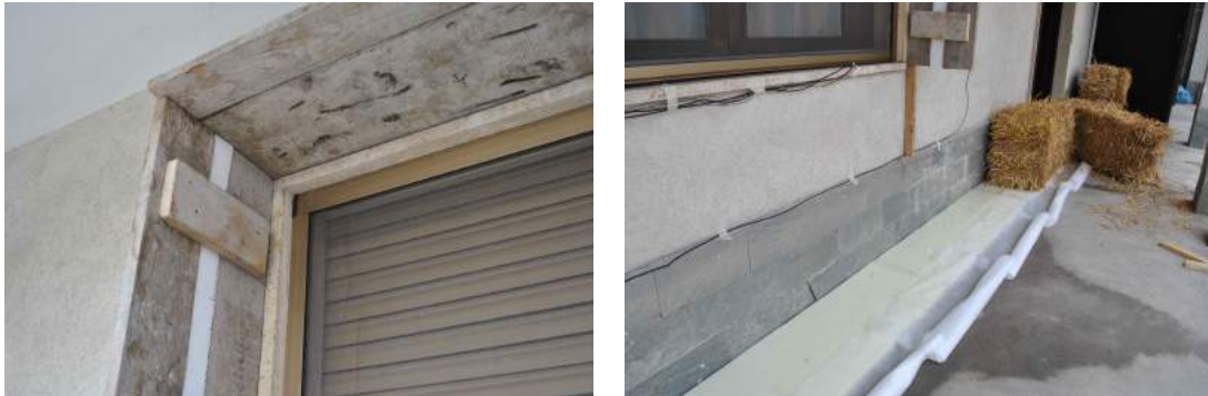
Figura 6.15: Particolare telaio finestra e pannelli isolanti prima della collocazione delle balle di paglia (A.R. Bertorello, 28.12.13)
