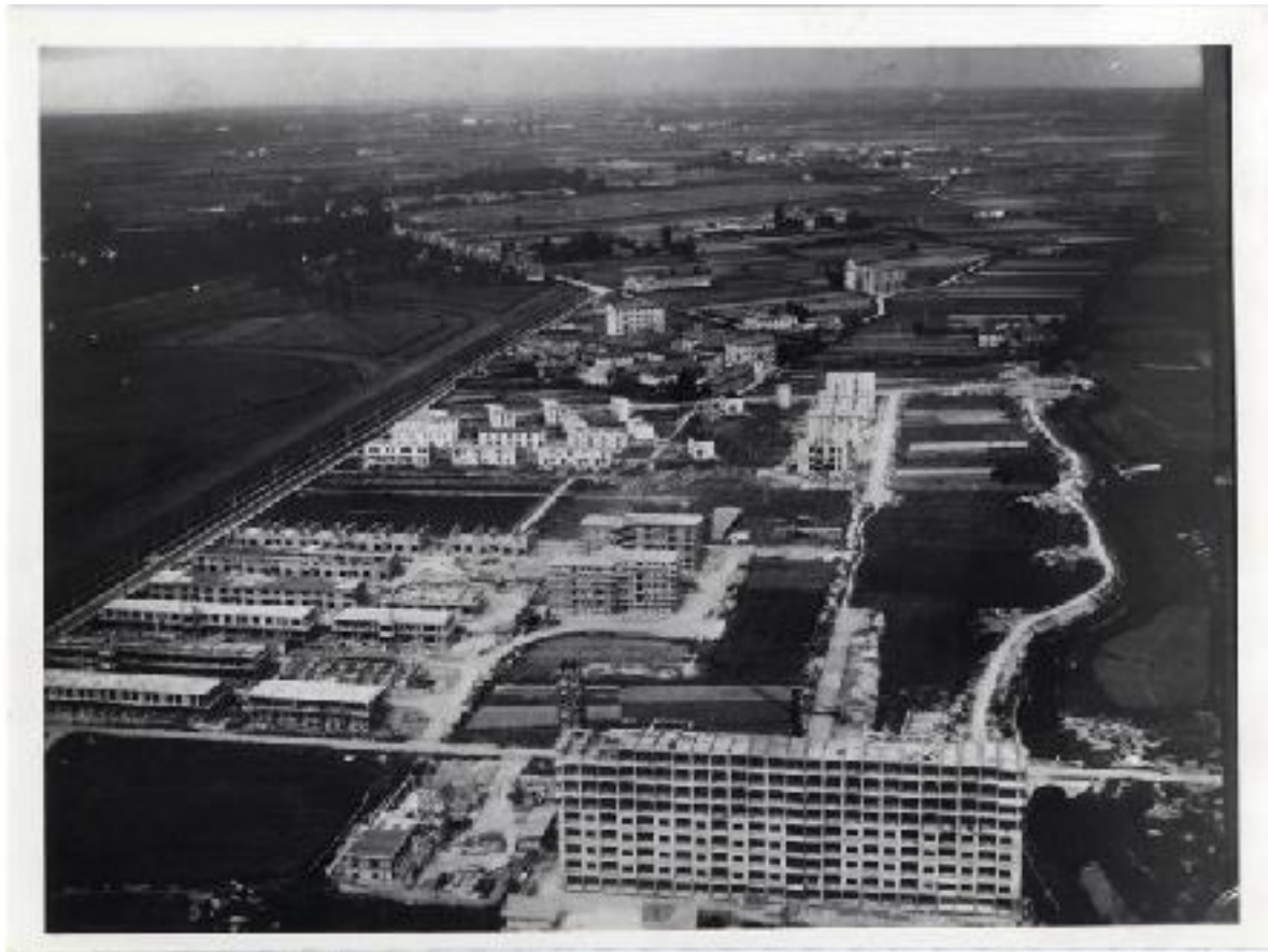
Fig. 4 - Il QT8 in costruzione (APTM)
