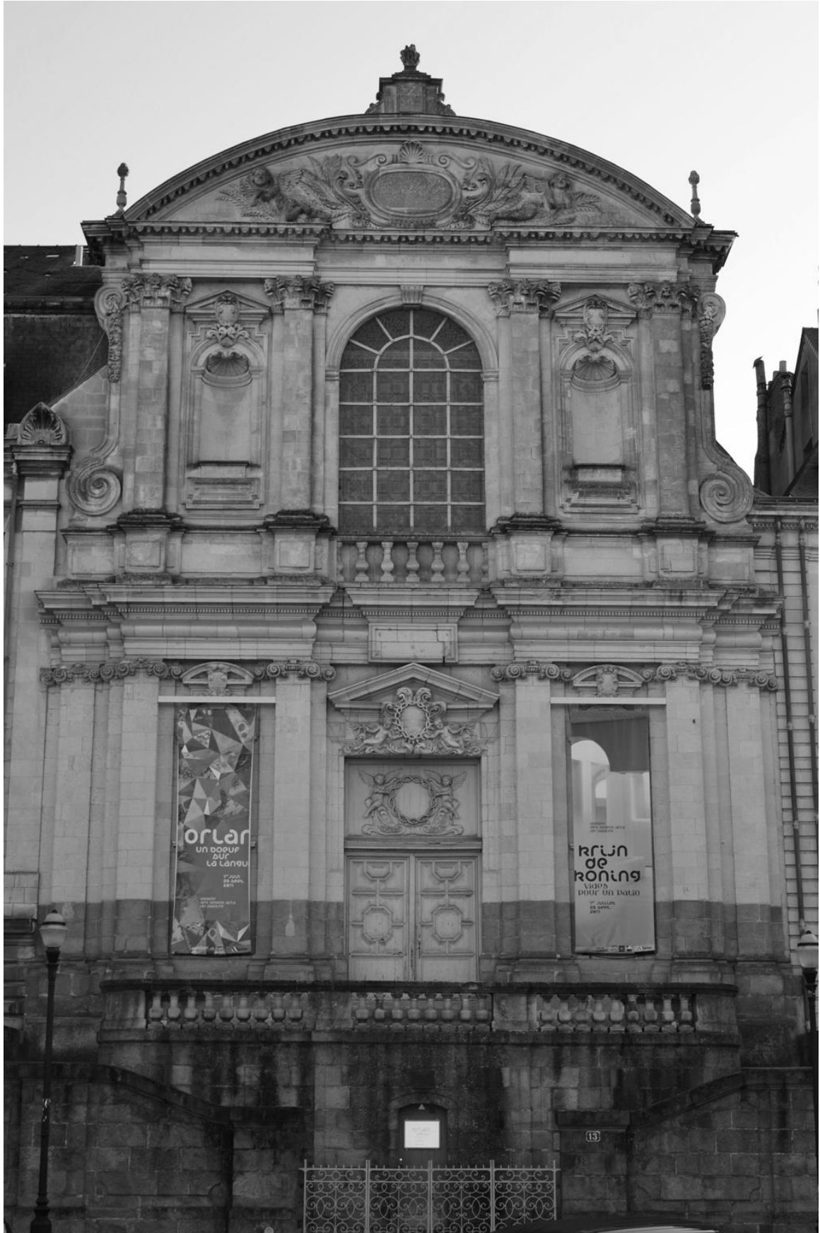
16. A.-L. de Sainte-Marthe (su progetto di), Facciata della chiesa dell'Oratorio di Nantes, 1654-1665.
