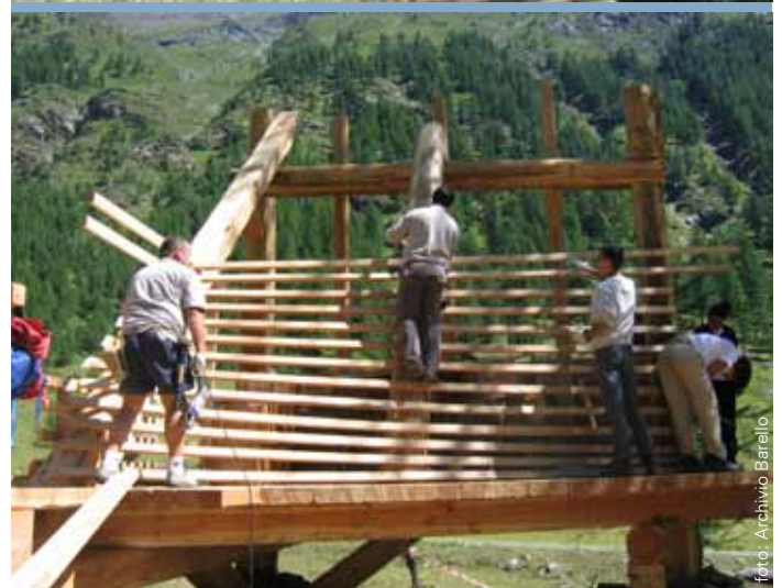
Fasi di montaggio della torretta
