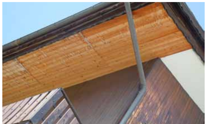
Sestriere. Rivestimenti parietali e cornicione (anni ottanta): alterazione cromatica, sfogliatura, degrado biotico, imbibizione.
