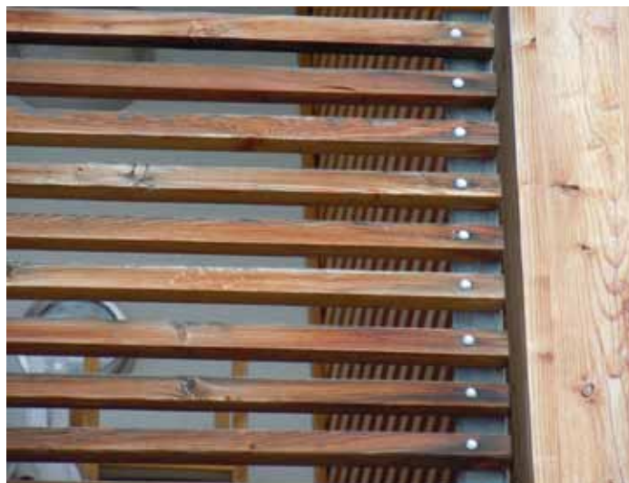
Sestriere. Intelaiature, balconate (2006): alterazione cromatica, cretti e abrasioni.
