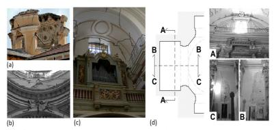
Figure 1: Damaged: (a) Dome, (b) Façade, (c) Transept, (d) Apse
