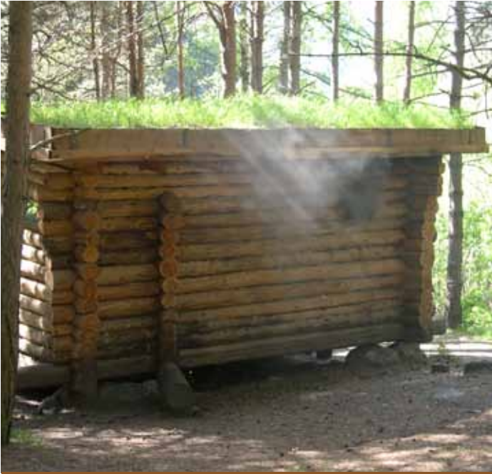
Tetto verde e prova di funzionamento della smoke-sauna (foto T. Marzi).
