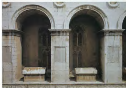
Roma, Colosseo, particolare della struttura interna Rimini, Tempio Malatestiano, particolare del fronte laterale
